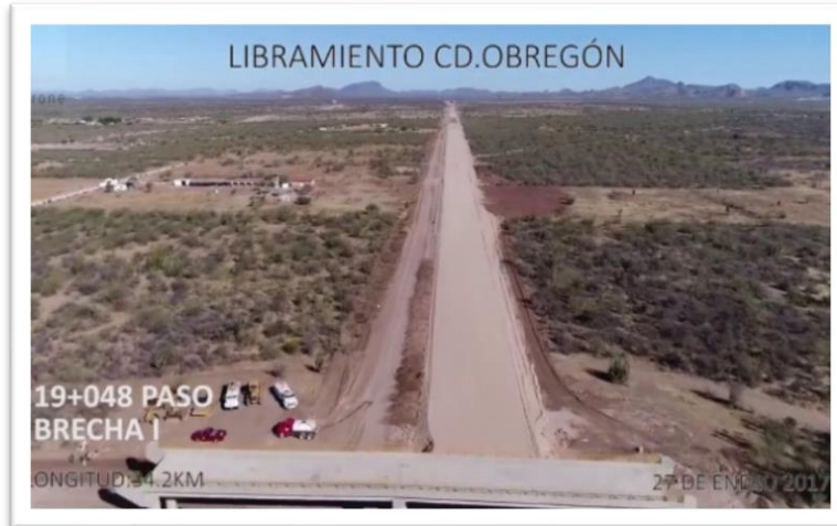
Fotografía 4. Paso a Desnivel sobre Vía
