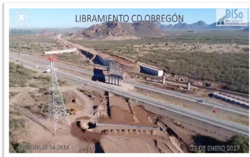
Fotografía 6. Construcción de Entronque
