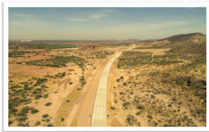
Fotografía 5. Construcción de la Carpeta Hidráulica
