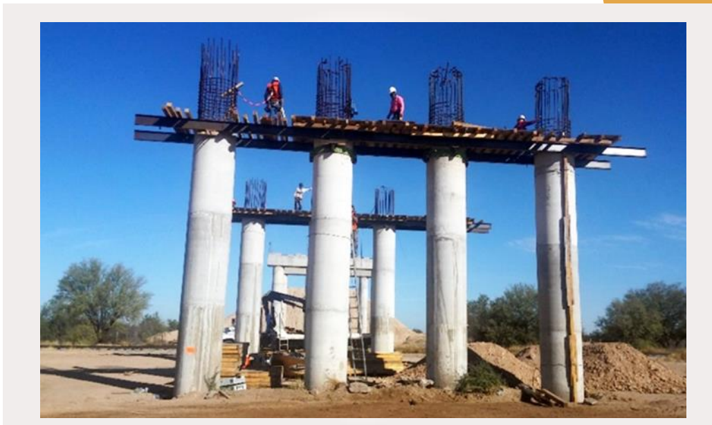
Fotografía 4. Trabajos en PSFC sin nombre armado de cabezales KM 19+776
