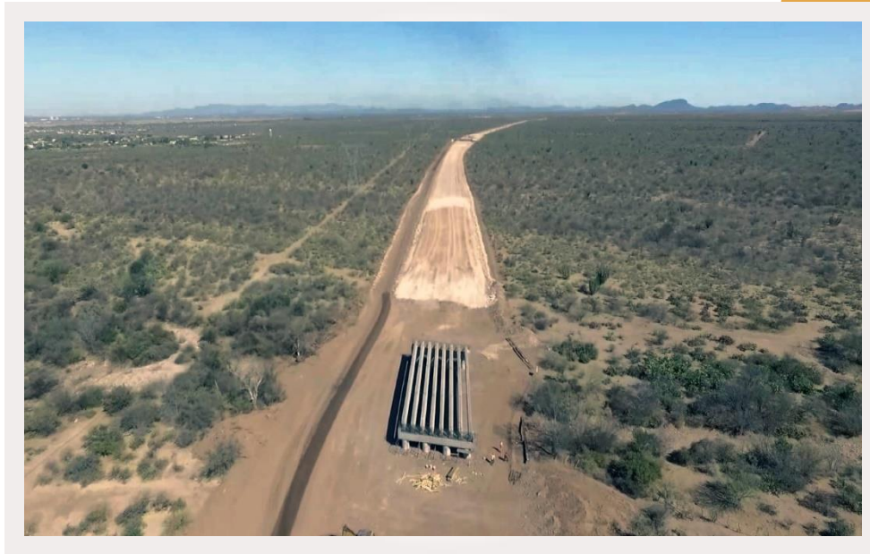
Fotografía 2. Vista del "Libramiento Hermosillo"
