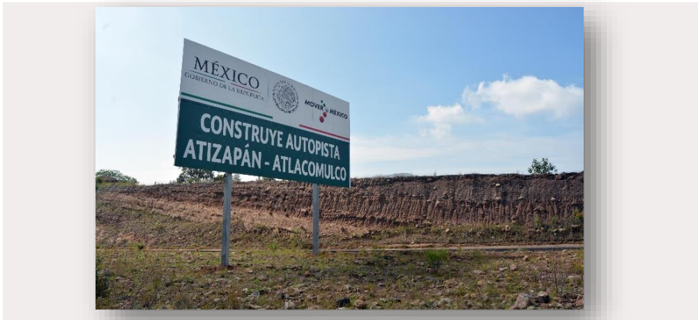
Fotografía 1. Obras de la Autopista
