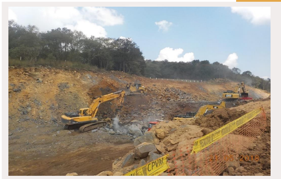
Fotografía 4. Ejecución de los trabajos de la autopista
