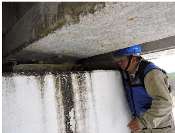
Figura 6.5-28. Levantamiento geométrico de dispositivos de apoyo
