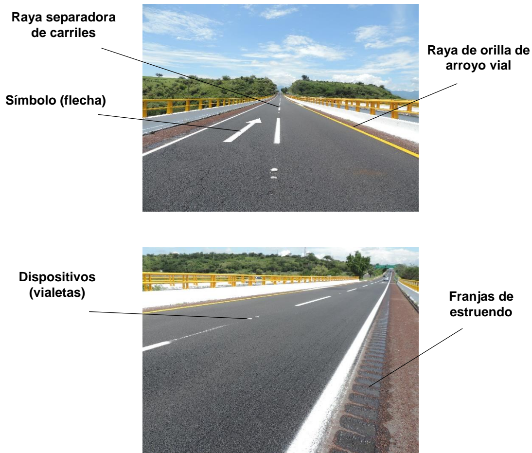
Figura 107. Diversos elementos de señalamiento horizontal
