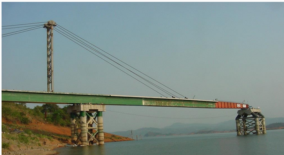
Fig 7.2 Puente Chiapas, Autopista Las Choapas-Ocozocuautla.
