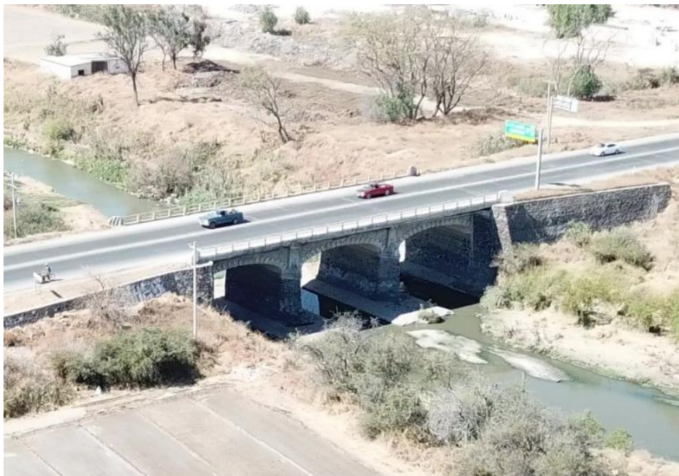
Figura 36. Ejemplo de puente de mampostería (Puente Guadalupe Victoria)
