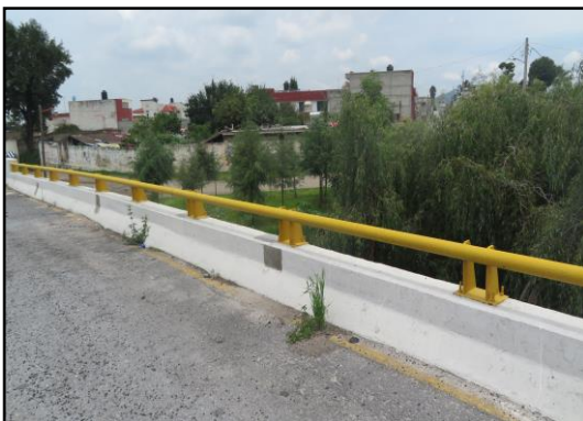
Figura 5.5-9 Vista general de la condición en drenes.
