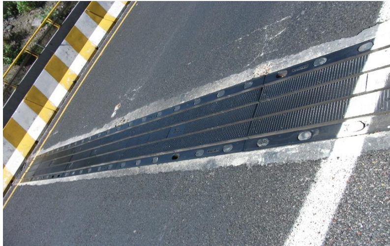
Figura 5.2-7 Ejemplo de Fotografía de Junta de Dilatación.
