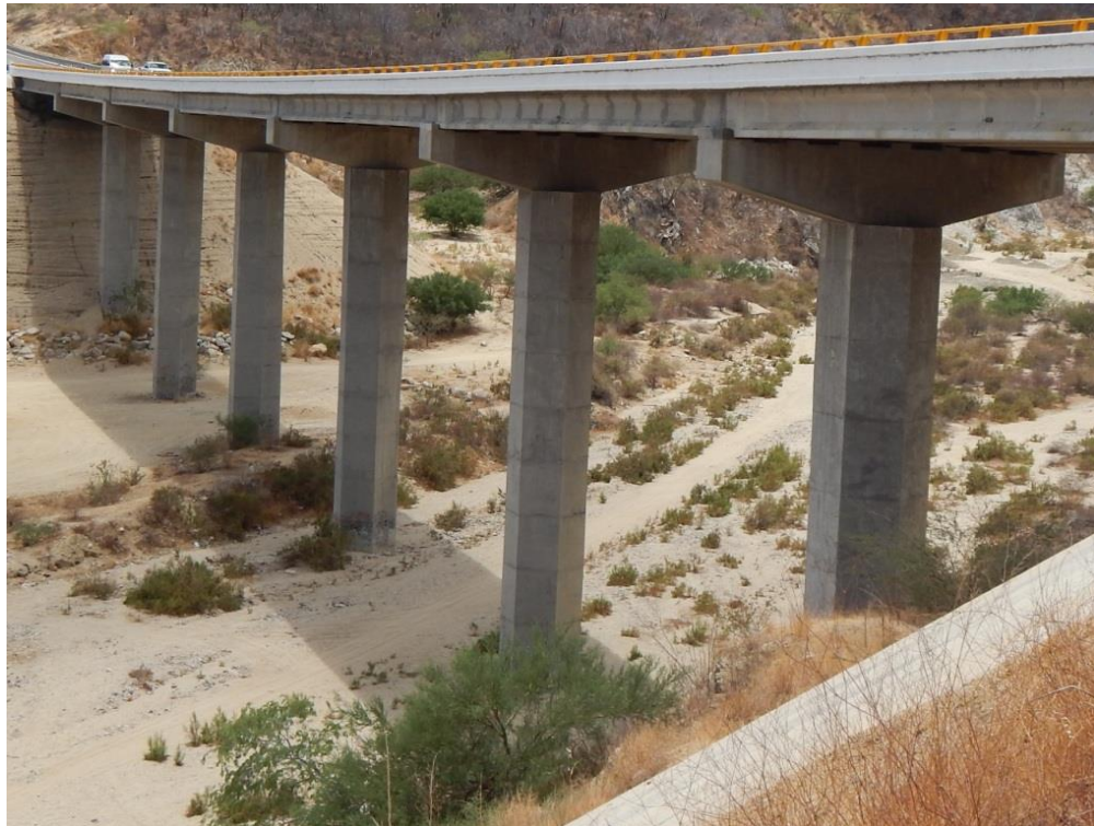
Figura 34. Ejemplo de puente con alineamiento vertical en columpio (Puente el Salto)
