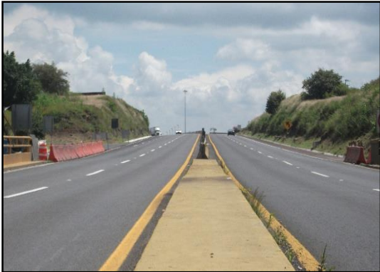
Figura 5.2-4 Ejemplo de fotografía general en acceso de entrada.
