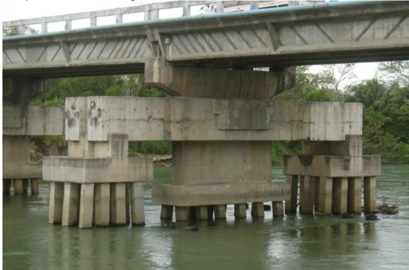
Figura 39. Ejemplo de puente de material compuesto de concreto y fibra de carbono (Puente La Isla)
