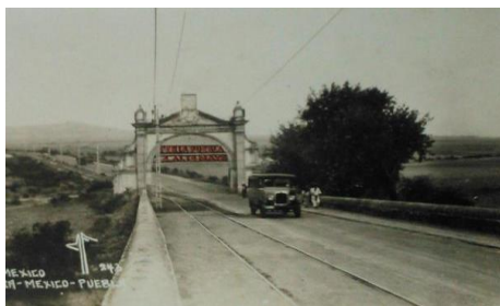
Fig 1.- Antigua Puente en la carretera México-Puebla
