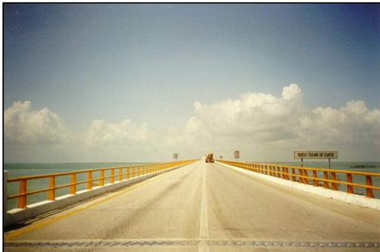
Figura 5.2-6 Ejemplo de fotografía, vista general de Superficie de Rodamiento.
