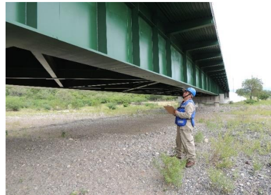
Figura 6.5-19. Inspección visual de la superestructura
