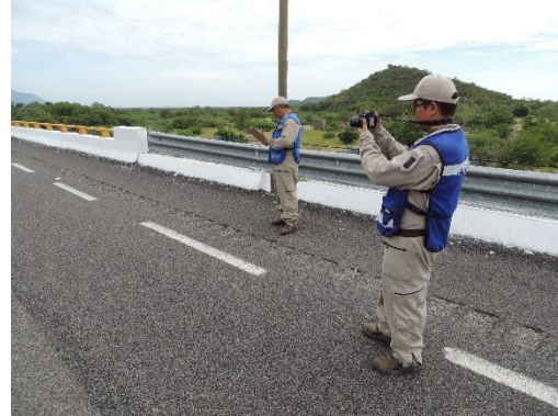
Figura 6.5-12. Inspección visual de la superficie de rodadura
