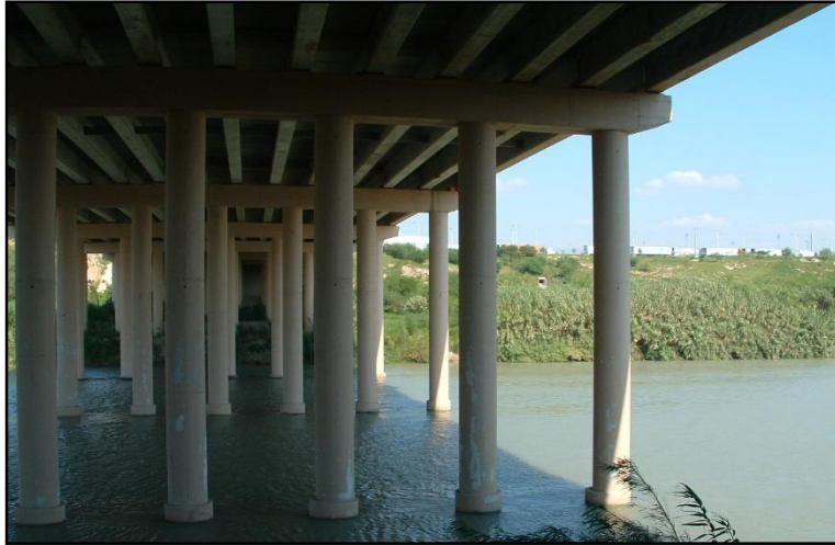
Figura 5.2-10 Ejemplo de Fotografía General de la Subestructura.
