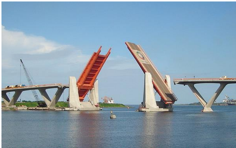
Figura 42. Ejemplo de puente basculante (Puente Albatros)
