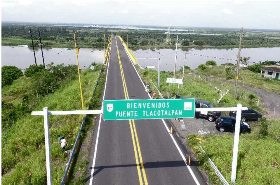
Figura 6.3-3. Señalamiento de identificación de la estructura
