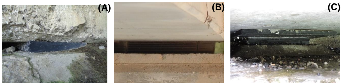
Figura 99. Tipos de apoyos de neopreno (A) Neopreno, (B) Neopreno integral y (C) Neopreno deslizante
