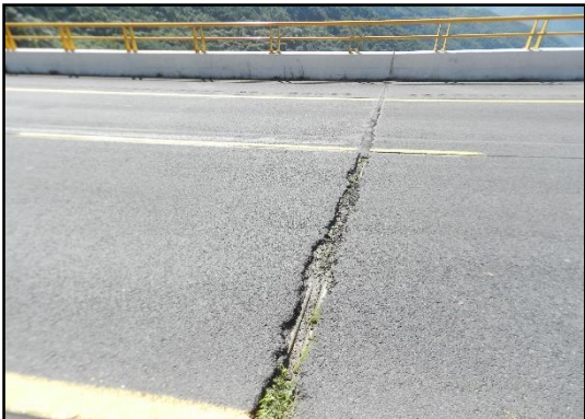
Figura 5.5-3 Vista general de daños en junta de dilatación.
