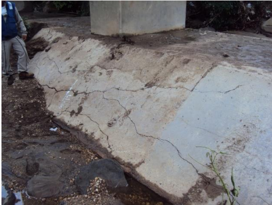
Figura 6.5-25. Inspección de cimentación
