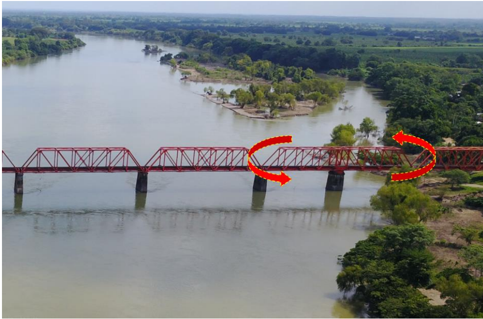
Figura 41. Ejemplo de puente Rotatorio (Puente Ferroviario Papaloapan)
