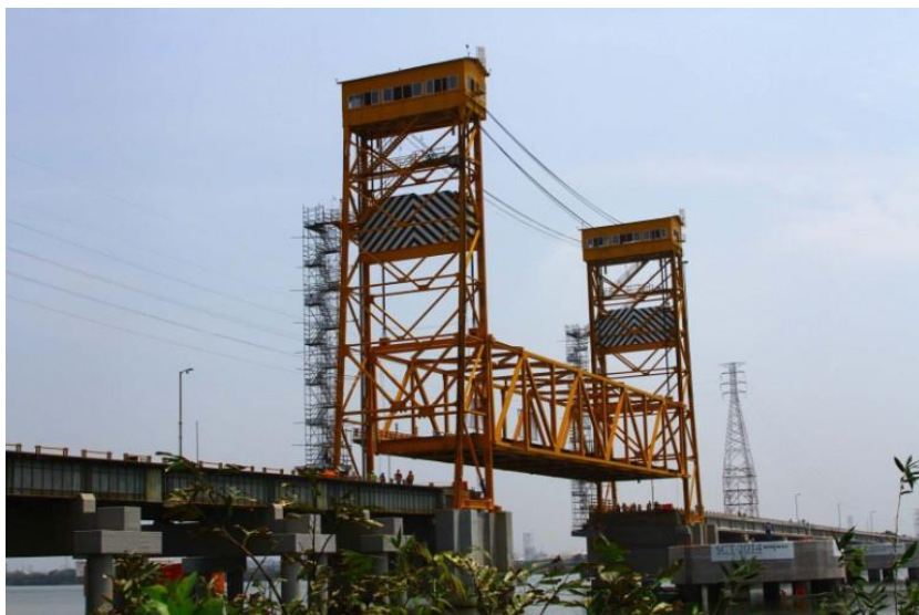
Figura 43. Ejemplo de puente levadizo (Puente Coatzacoalcos I)
