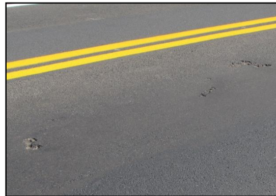
Figura 5.5-8 Vista de detalle.
