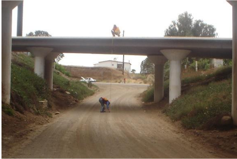
Figura 6.5-33. Verificación de gálibo
