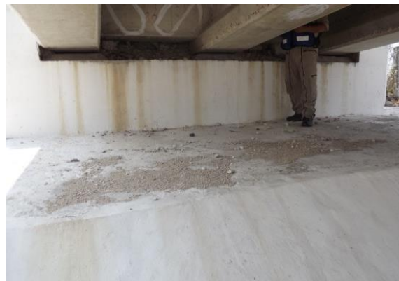
Figura 6.5-17. Inspección visual de la superestructura
