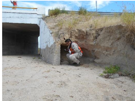
Figura 6.5-22. Inspección visual en subestructura
