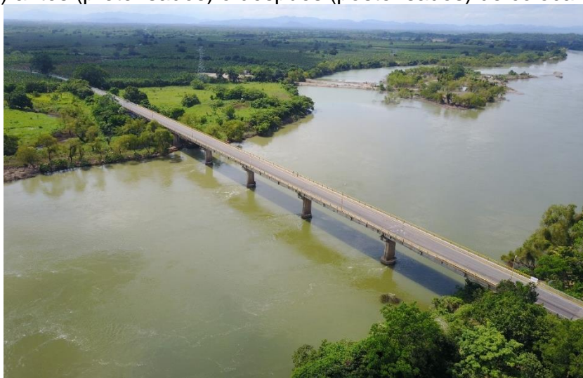
Figura 37. Ejemplo de puente de concreto (Puente Papaloapan)
