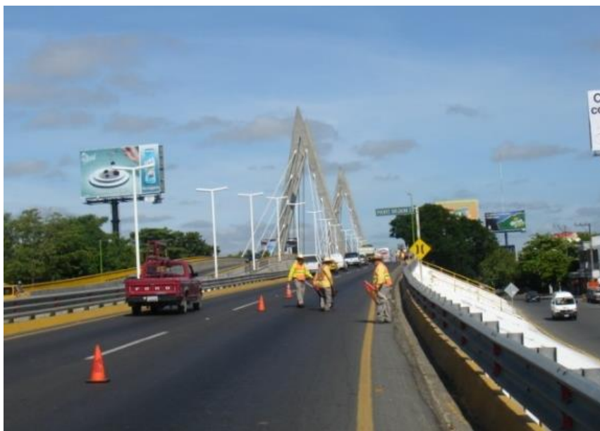
Figura 6.3-4. Señalamiento de protección para inspección de la calzada
