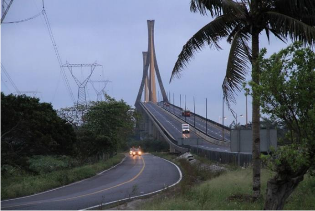
Fig 8.- Puente Antonio Dovalí Jaime
