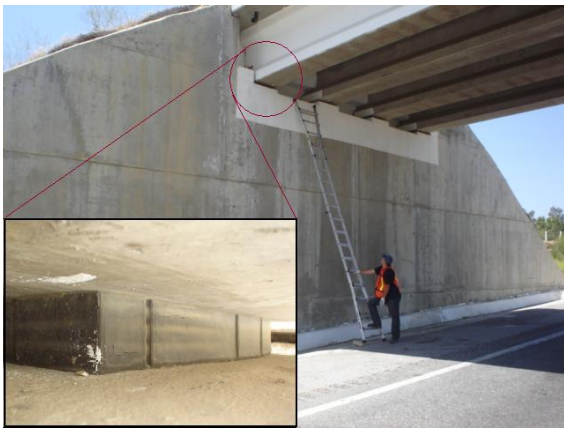
Figura 6.5-27. Inspección de dispositivos de apoyo con equipo de aproximación simple
