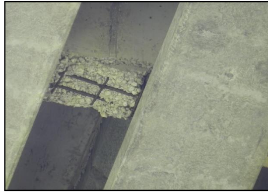
Figura 5.5-14 Vista de detalle.
