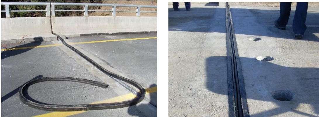
Figura 61. Ejemplos de junta metálica sin sello fijo
