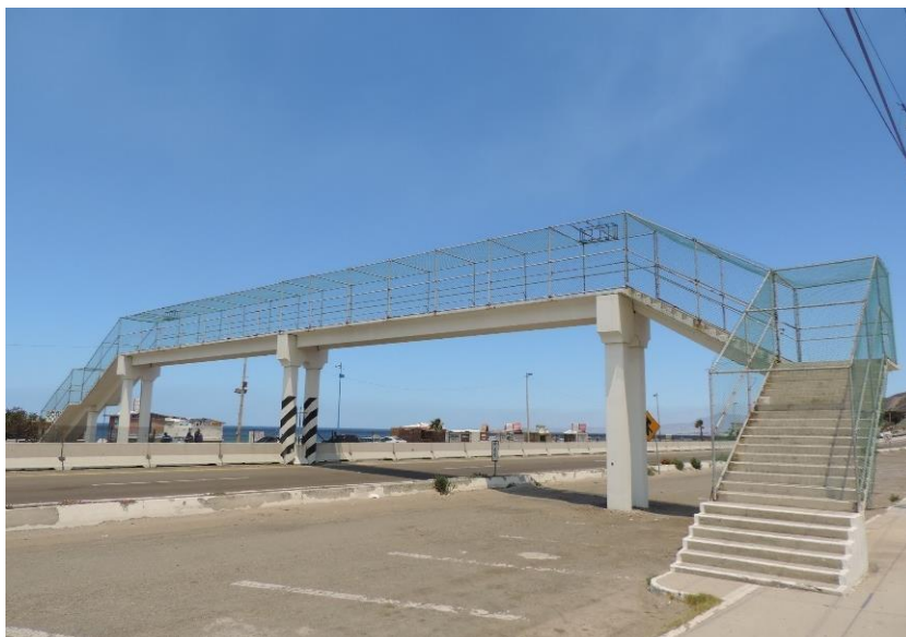
Figura 23. P.I.P. Km 69+000 de la Autopista Tijuana-Ensenada
