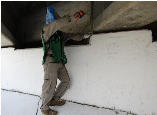
Figura 6.5-18. Levantamiento geométrico de la superestructura
