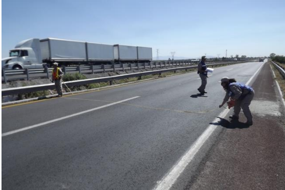
Figura 6.5-11. Levantamiento geométrico de la calzada
