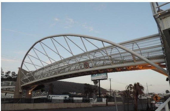
Figura 13. P.I.P. Km 105+000 de la Autopista Tijuana-Ensenada
