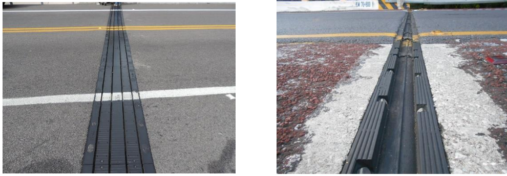
Figura 57. Ejemplos de juntas elastoméricas reforzada y no reforzada
