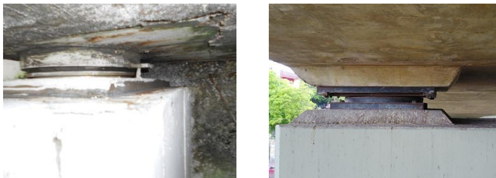
Figura 103. Apoyos tipo cazoleta o pot
