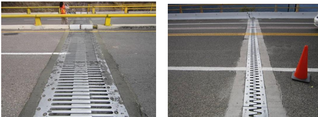
Figura 65. Ejemplos de junta dentada
