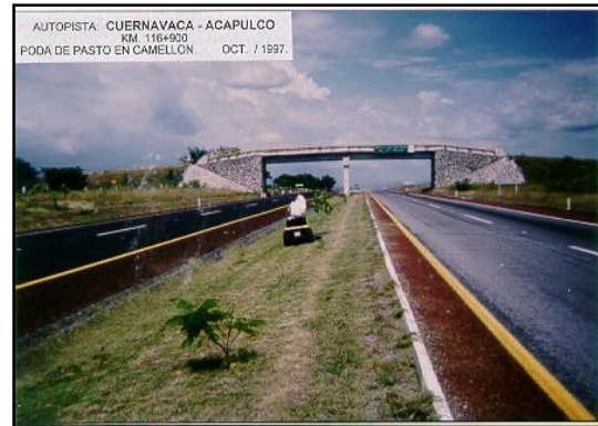
Figura 5.2-2 Ejemplo de fotografía de identificación (cuando no existe señalamiento).
