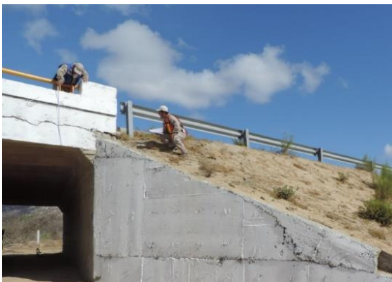
Figura 6.5-16. Levantamiento geométrico de la superestructura
