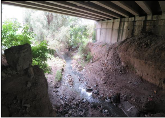
Figura 5.5-17 Vista general de la condición del cauce.
