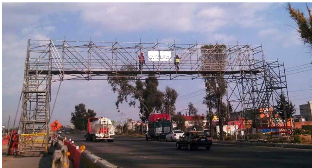
Figura 44. Ejemplo de P.I.P. temporal (P.I.P. sobre Autopista México - Puebla)
