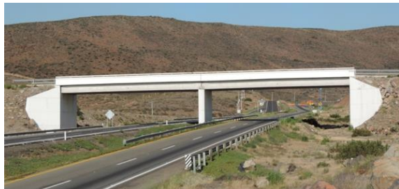
Figura 8. P.I.V. Gasera km 80+720 Autopista Rosarito-Ensenada
