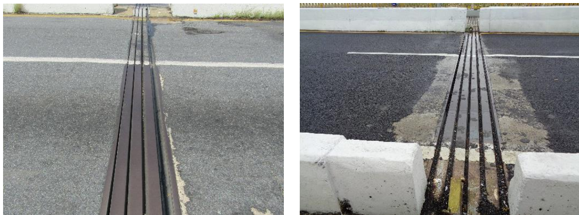
Figura 67. Ejemplos de junta modular
