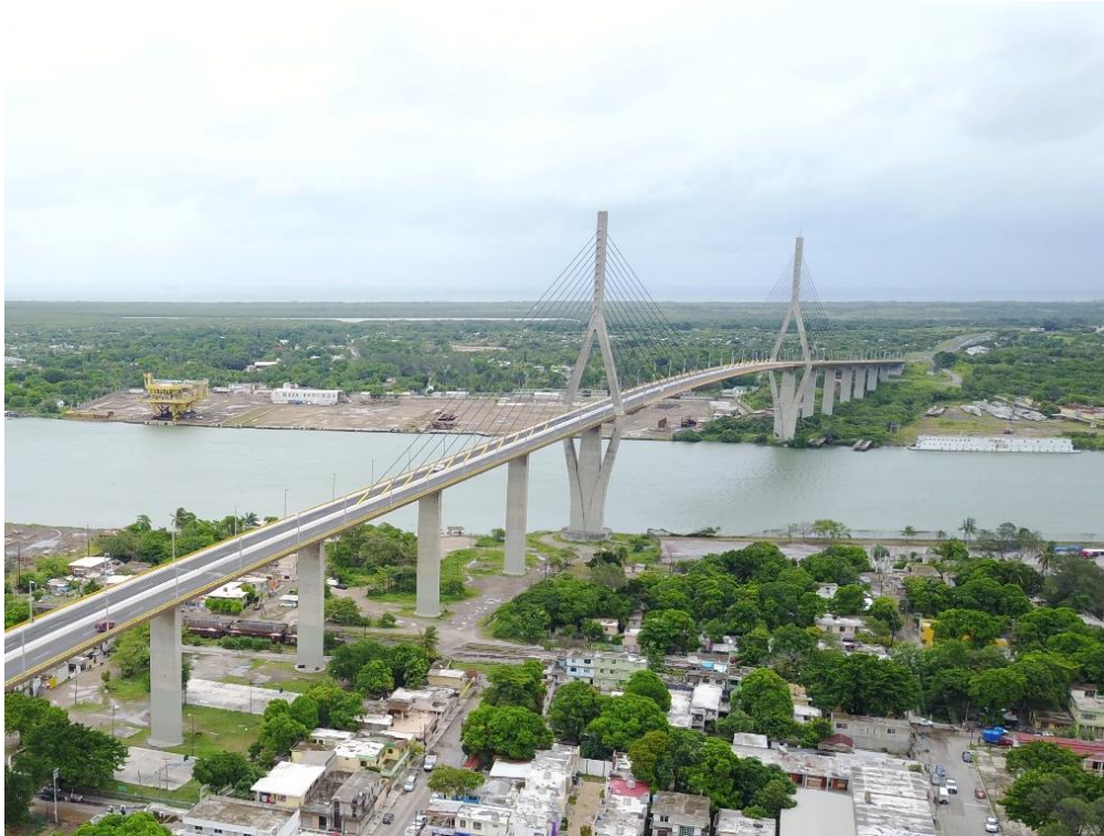
Figura 33. Ejemplo de puente con alineamiento vertical en cresta (Puente Tampico)
