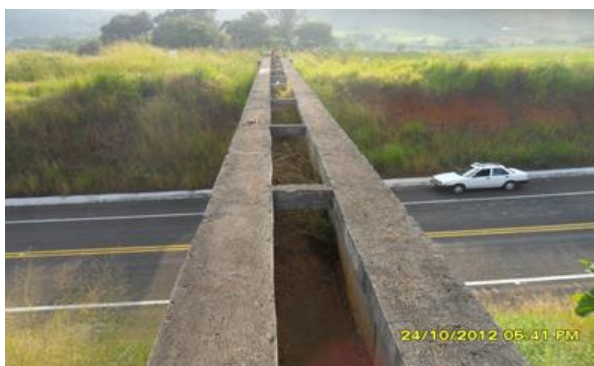
Figura 17. Puente canal autopista Tehuacán – Oaxaca.
