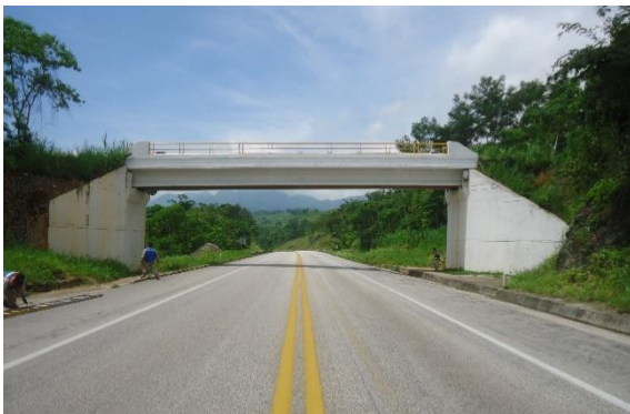
Figura 15. P.I.G. Km 161+080 de la Autopista Raudales-Ocozocoautla
