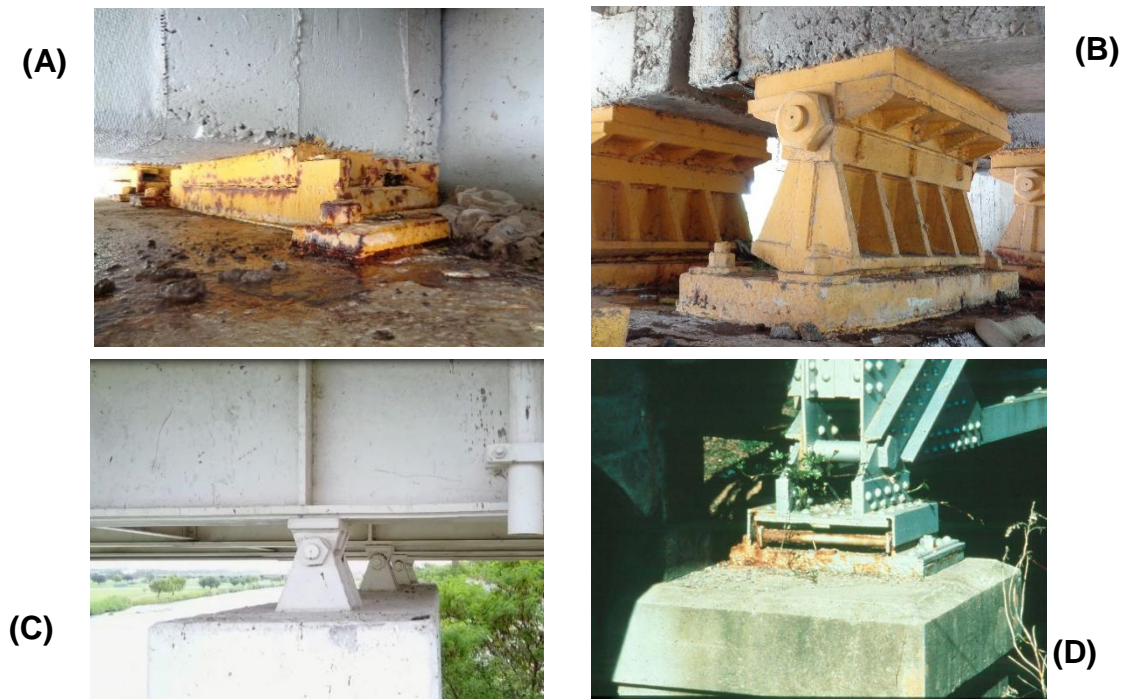
Figura 100. Tipos de apoyos metálicos, (A) fijos, (B) de tipo mecedora, (C) tipo pasador y (D) rodillos metálicos
