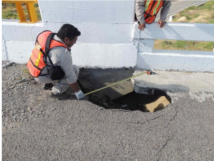
Figura 6.5-29. Inspección y reporte de daños en losas de acceso
