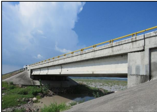
Figura 5.2-11, a) Vista aguas arriba, Ejemplo de fotografía General del cauce.
