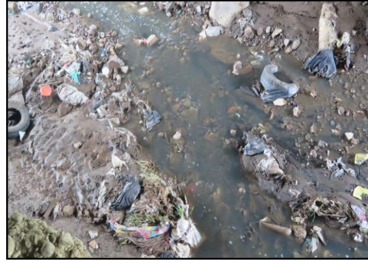
Figura 5.5-18 Vista de detalle.
