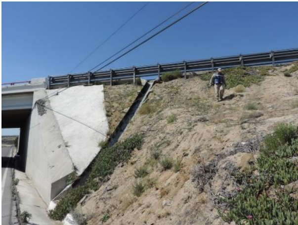
Figura 6.5-30. Inspección de de taludes
