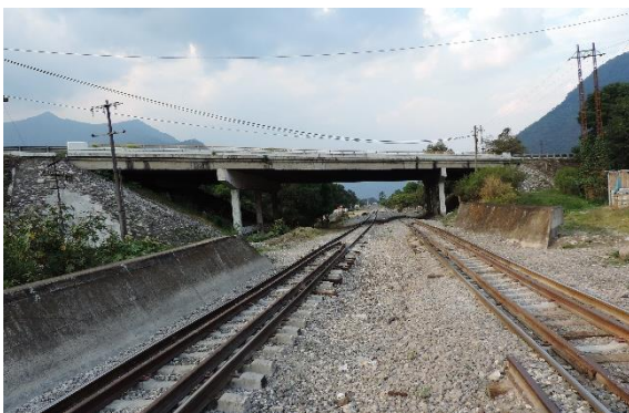
Figura 9. P.S.F. San Miguelito Km 263+700 de la Autopista Cd. Mendoza-Córdoba
