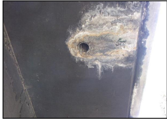
Figura 5.5-12 Vista de detalle.
