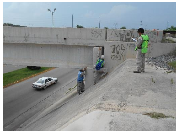
Figura 6.5-24. Inspección visual de la subestructura
