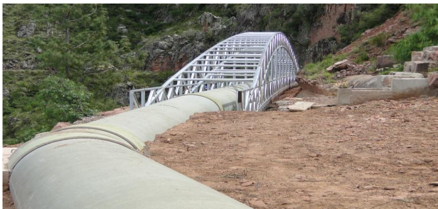
Figura 18. Puente ducto metálico Socapampa, Bolivia
