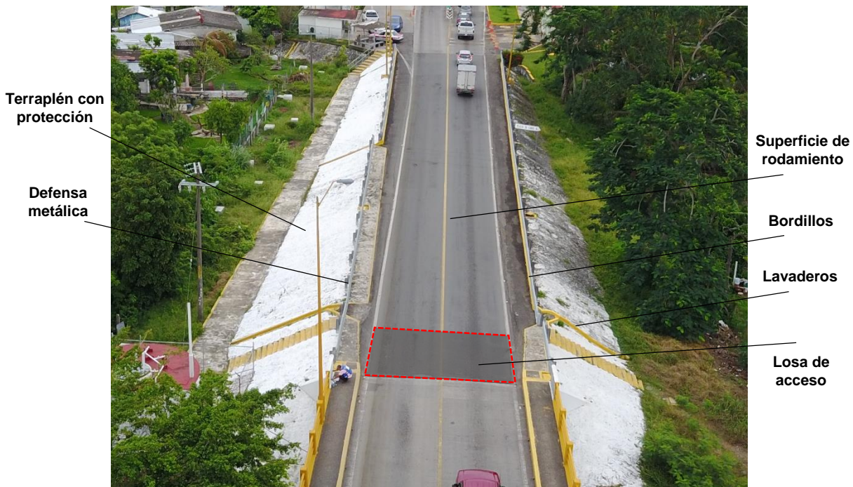
Figura 105. Elementos existentes en el acceso de un puente o estructura similar
