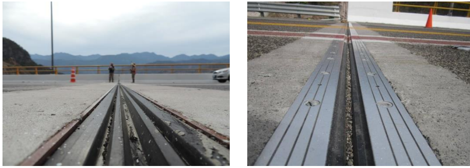
Figura 63. Ejemplos de junta metálica con sello fijo
