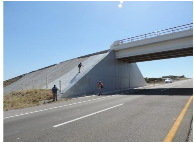
Figura 6.5-31. Inspección de losas de protección en taludes
