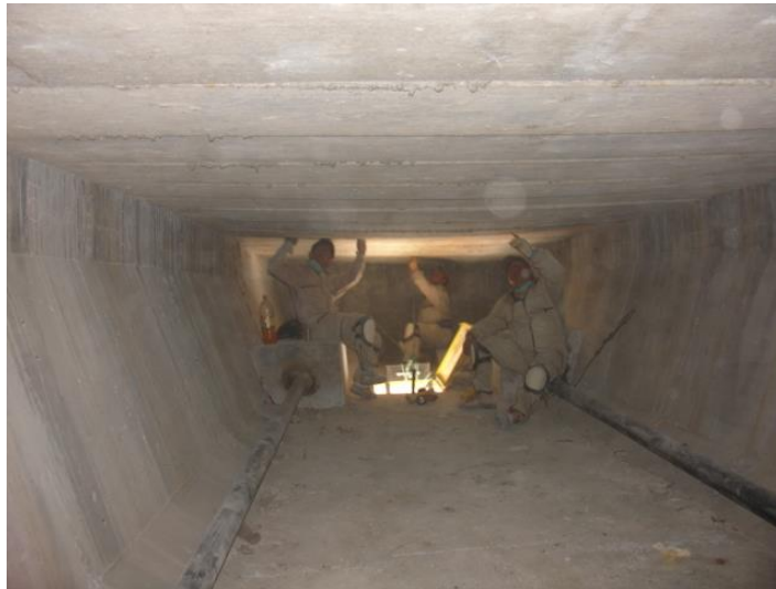
Figura 6.5-20. Inspección visual de superestructura tipo cajón
