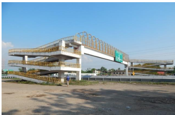
Figura 14. P.I.P. Km 27+700 de la Autopista Nuevo Teapa-Cosoleacaque
