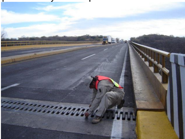
Figura 6.5-13. Levantamiento geométrico de la junta de dilatación
