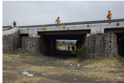
Figura 6. 1-2. Brigada de inspección
