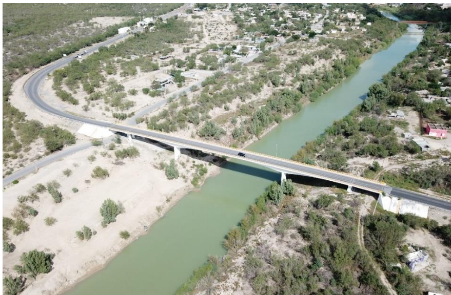
Figura 40. Ejemplo de Puente fijo (Puente San Juan)
