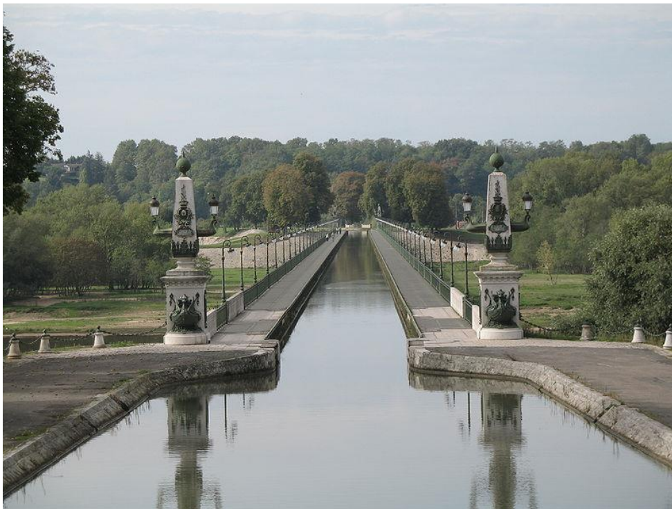
Figura 22. Puente canal Briare, Francia
