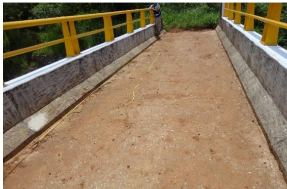
Figura 16. P.I.G. Km 161+080 de la Autopista Raudales-Ocozocoautla
