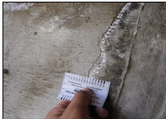
Figura 5.5-16 Vista de detalle.
