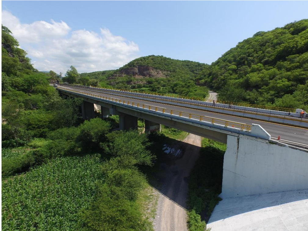
Figura 31. Ejemplo de puente con alineamiento vertical en tangente horizontal (Puente Temoaya II)
