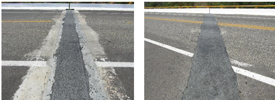
Figura 59. Ejemplos de juntas asfálticas
