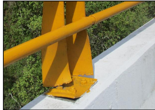
Figura 5.5-6 Vista de detalle.
