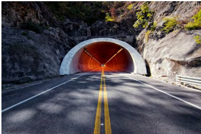
Figura 15.2. Luminancia al interior del túnel.
