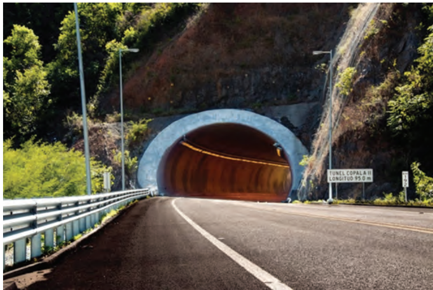
Figura 15.4. Alumbrado de túnel corto con curvatura.
