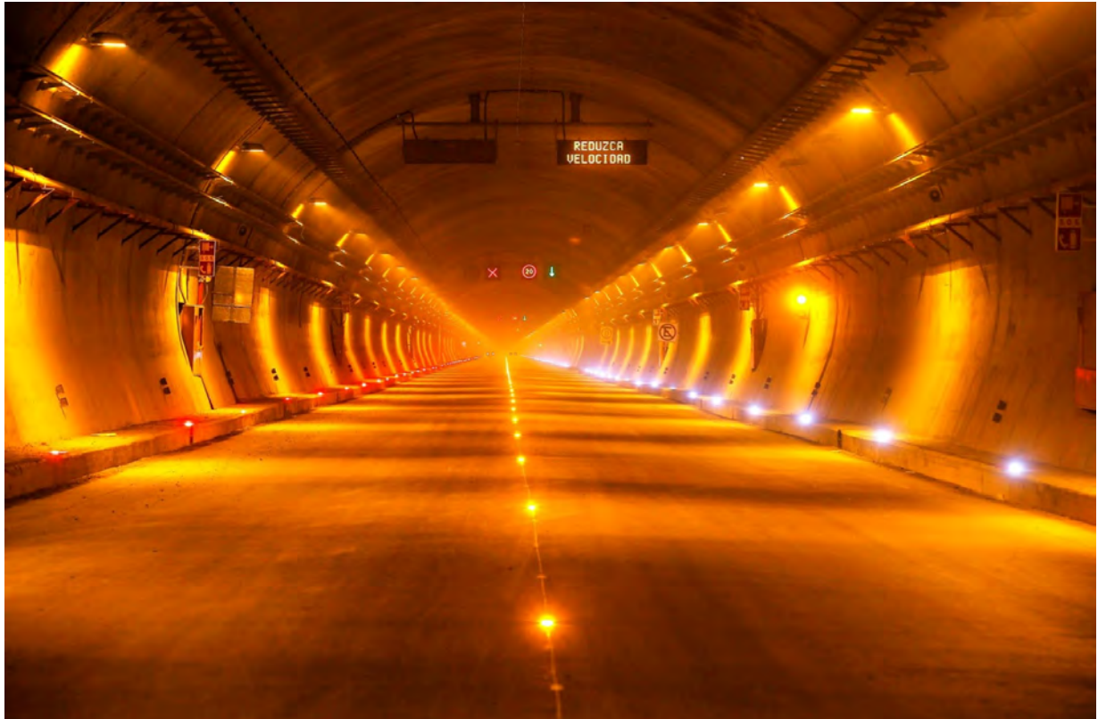
Túnel El Sinaloense, Carretera Durango-Mazatlán
