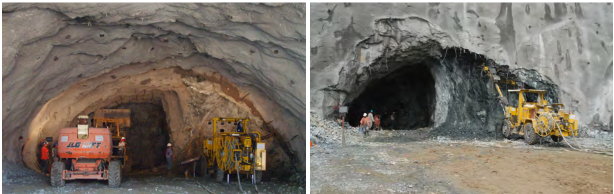
Figura 7.5. Excavación de la media sección superior en dos fases.
