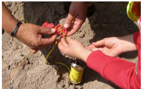
Figura 7.35. Realizando la conexión a la línea troncal del circuito.
