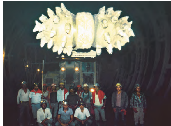
Figura 7.45. Rozadora utilizada en el túnel "Libramiento Puerto Vallarta" 1980.
