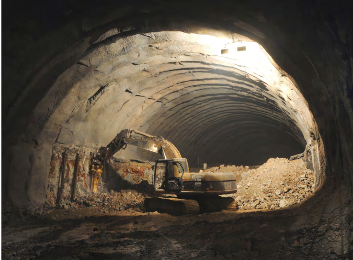
Túnel Piedra Colorada, Carretera Durango-Mazatlán
