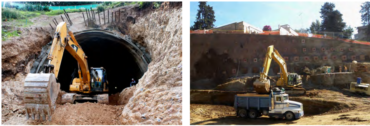
Figura 7.58. Excavadora frontal.
