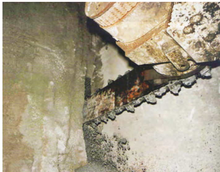
Figura 7.47. Ejecución de precorte mecánico. Tomada de Lunardi (2008).
