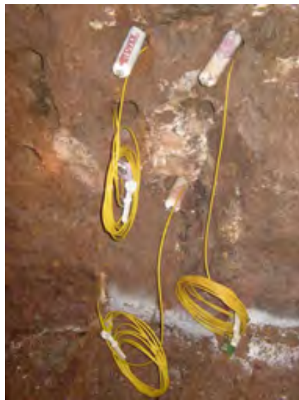
Figura 7.11. Cartuchos colocados en barrenos.
