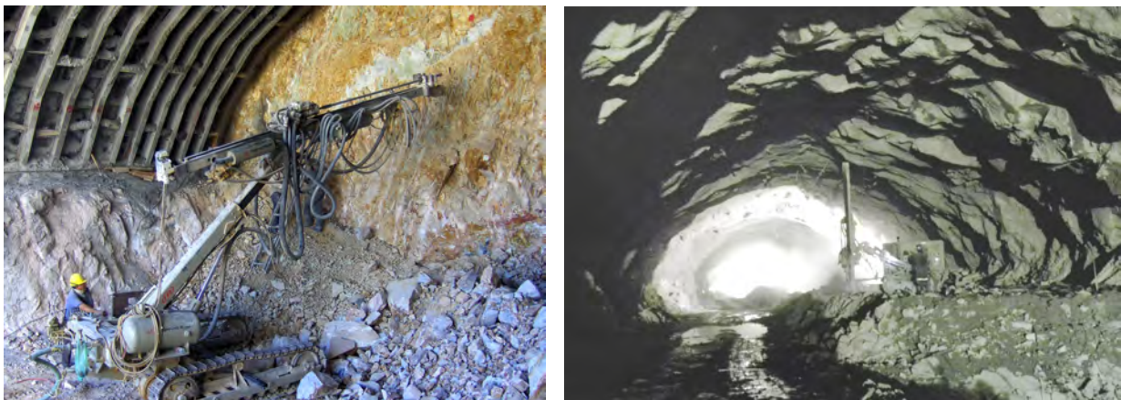
Figura 7.19. Uso de Track–drill en Media sección superior y banqueo.
