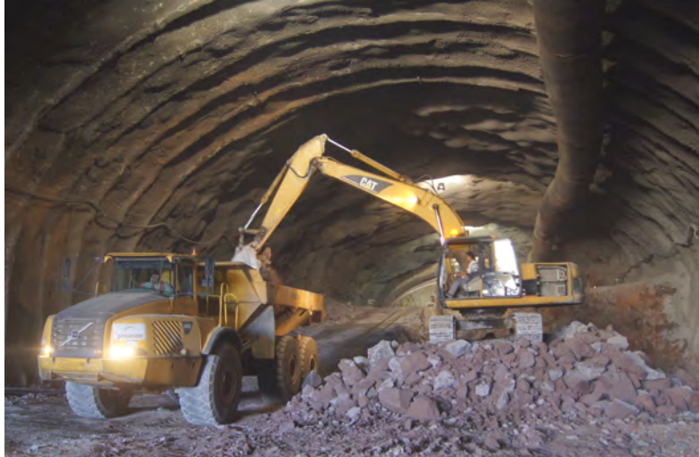
Figura 7.15. Retiro de material.
