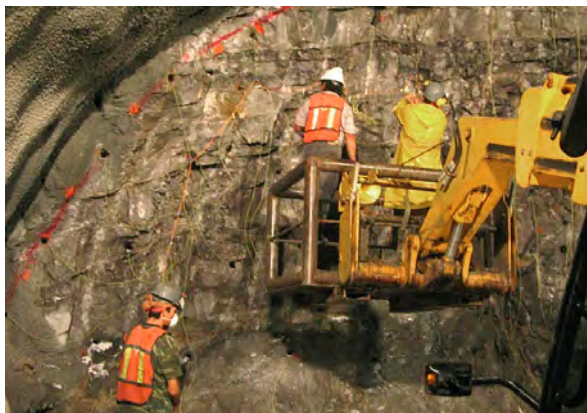
Figura 7.30. Cargando una frente.
