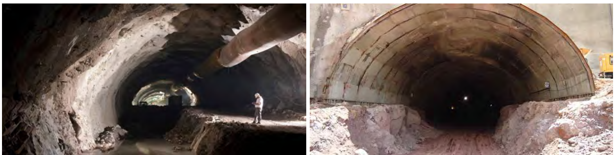
Figura 7.6. Excavación del banqueo en fases.
