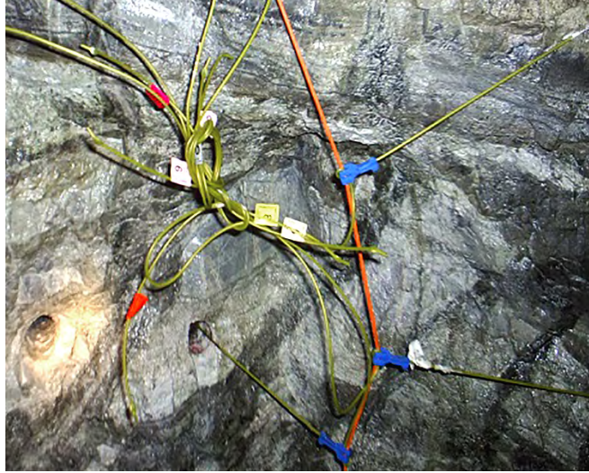
Figura 7.32. Conexión de los iniciadores con cordón detonante.
