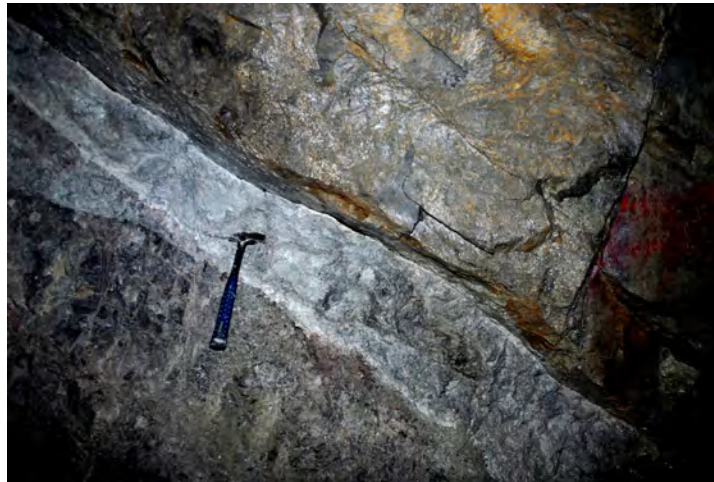
Figura 6.22. Detalle de la falla.
