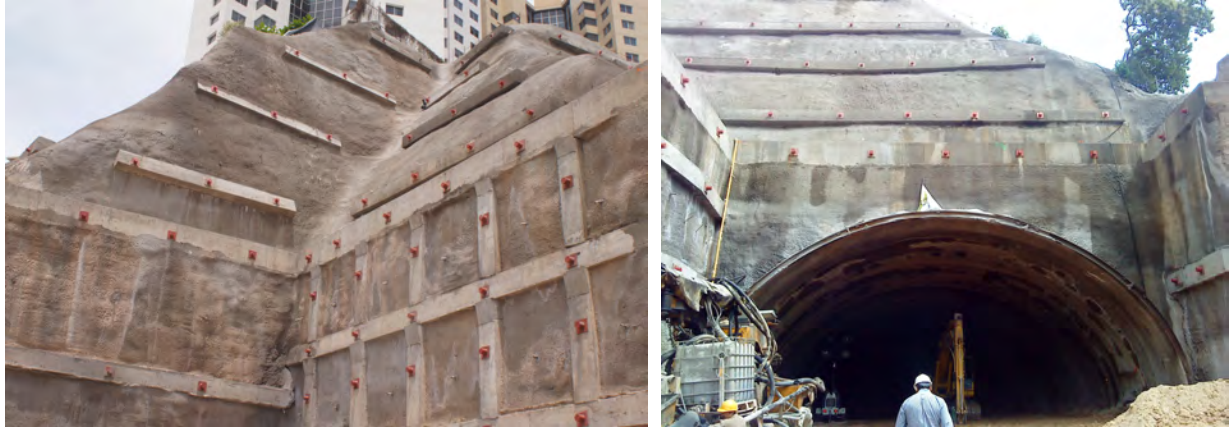
Figura 5.40. Anclas de tensión en viga de atado.
