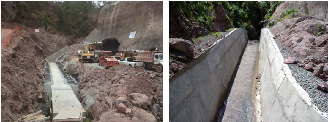
Figura 5.35. Obras de desvío mediante canales.
