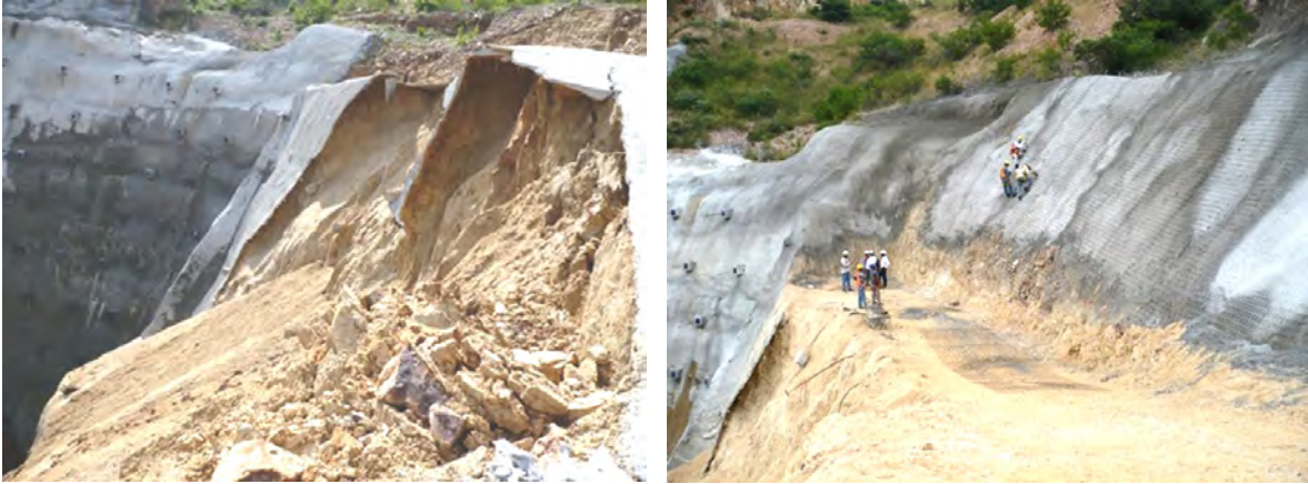
Figura 5.28. Abatimiento de talud.
