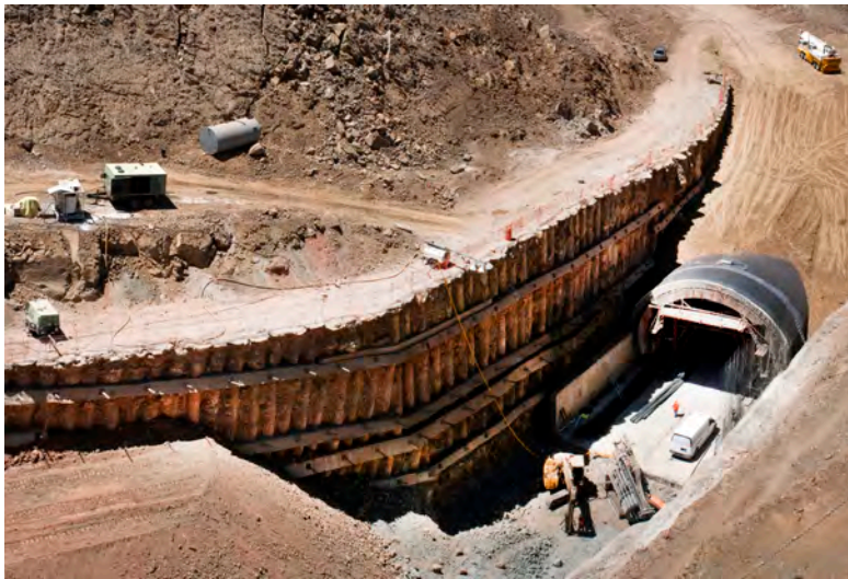
Figura 5.37. Pantalla de pilotes con anclas de tensión en taludes.
