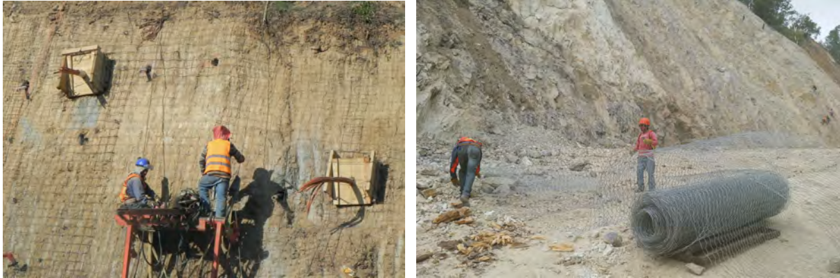
Figura 5.31. Malla electrosoldada y de triple torsión en taludes.
