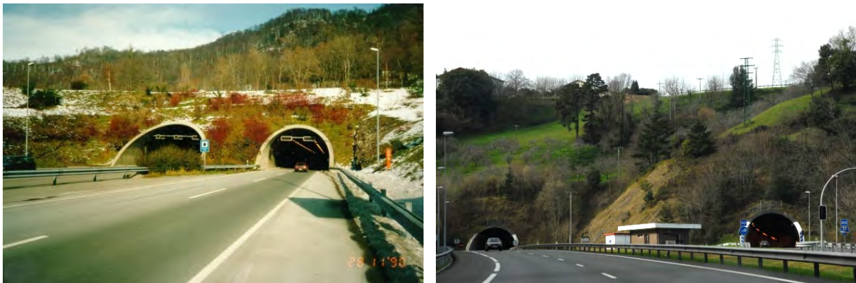
Figura 5.48. Ejemplo de túneles falsos paisajísticos.
