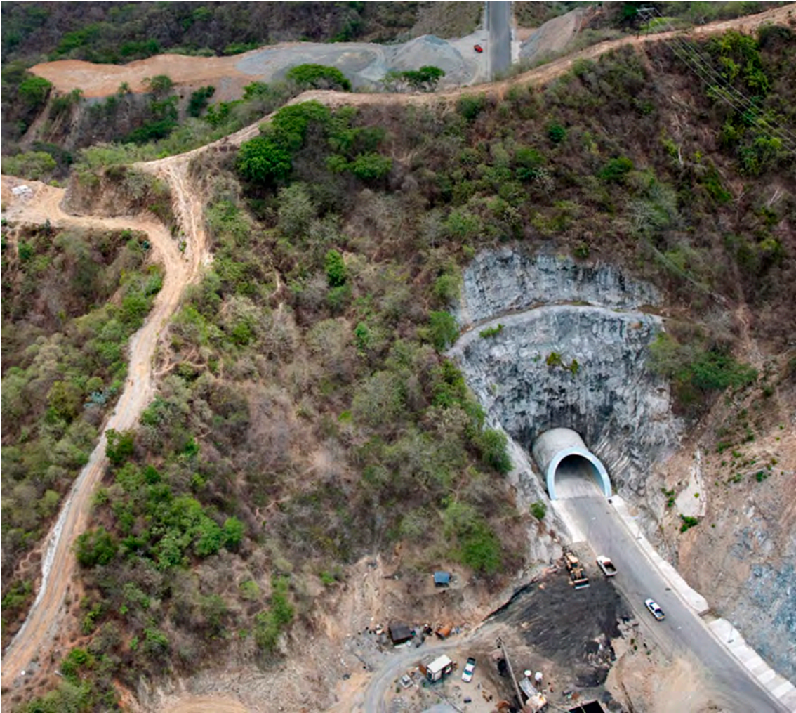
Portal Mazatlán del Túnel Las Charcas. Autopista Durango-Mazatlán. SCT (2011)
