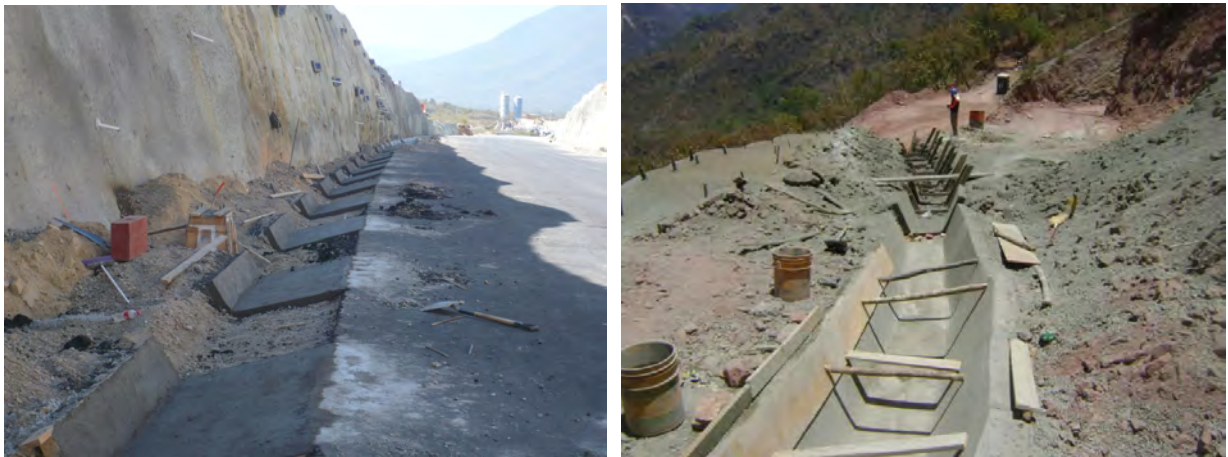
Figura 5.33. Construcción de cunetas y contracunetas.
