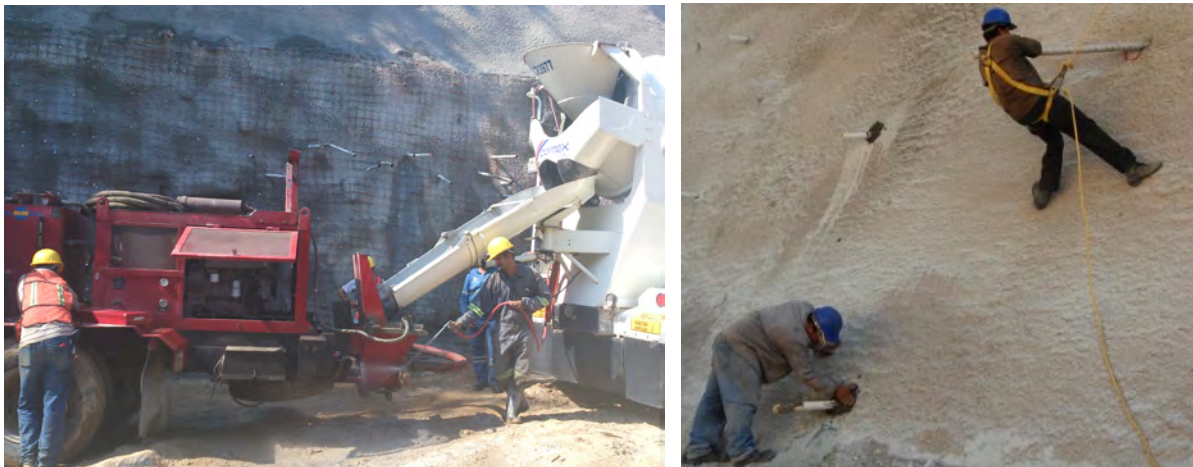
Figura 5.34. Barrenación y colocación de drenes horizontales.
