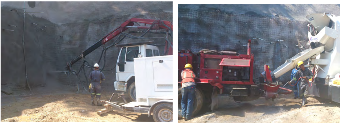
Figura 5.32. Colocación de concreto lanzado en taludes.
