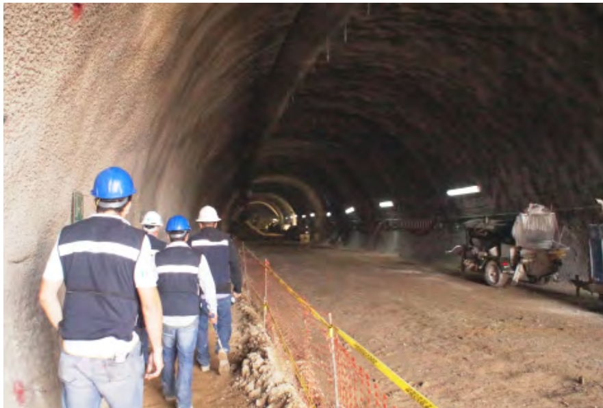
Figura 18.15. Personal de obra circulando por los espacios destinados para el tránsito peatonal.
