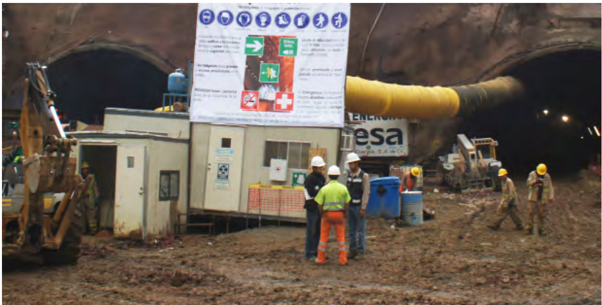
Figura 18.6. El uso obligatorio de los equipos de protección personal, quedará indicado en la zona del portal.
