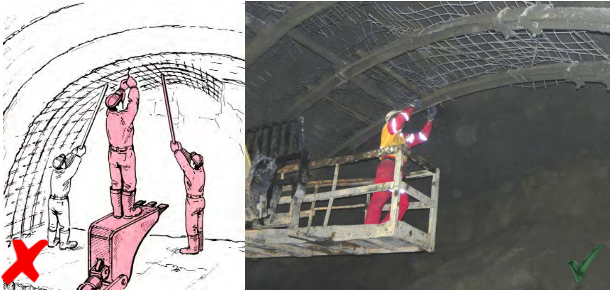
Figura 18.35. Colocación de mallas de protección sobre la clave del túnel con apoyo de un manipulador telescópico con plataforma.
