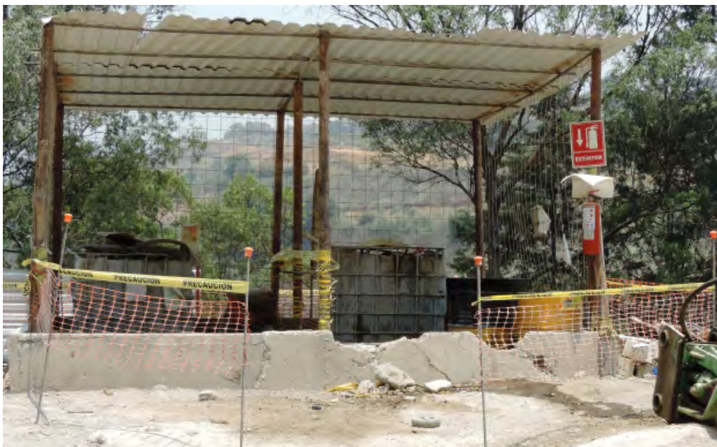
Figura 18.21. Almacén de residuos peligrosos con señalización y extintor propio.
