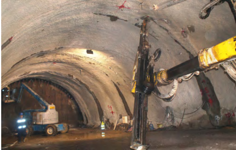
Figura 18.45. Perforación de barreno para dren al interior del túnel.
