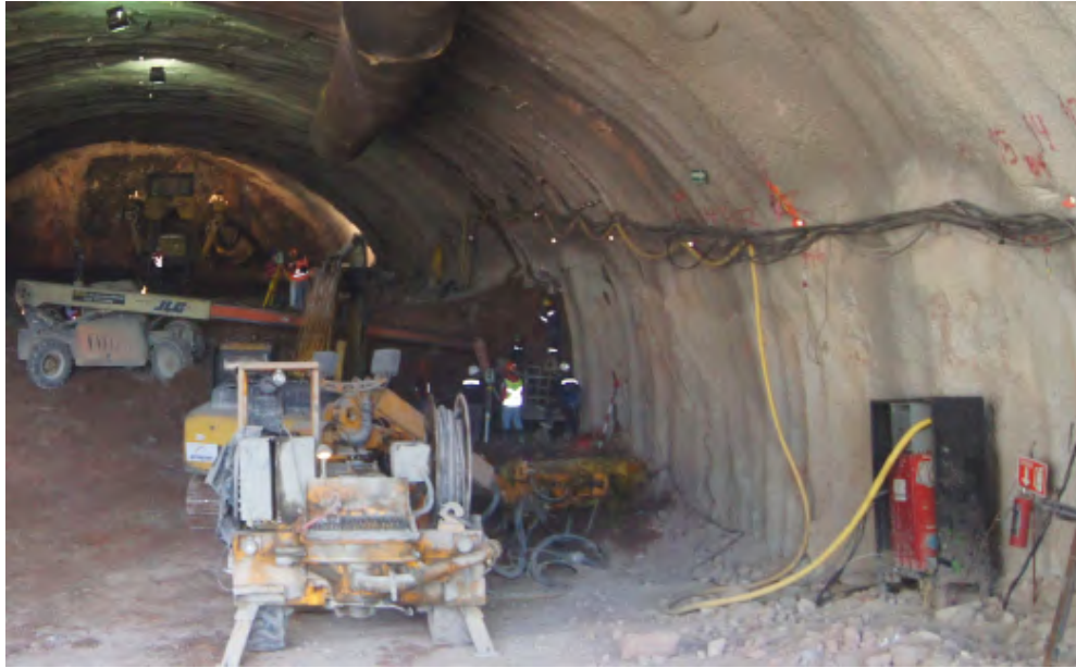
Figura 18.19. Extintor colocado próximo al desarrollo de los trabajos teniendo fácil acceso a el.
