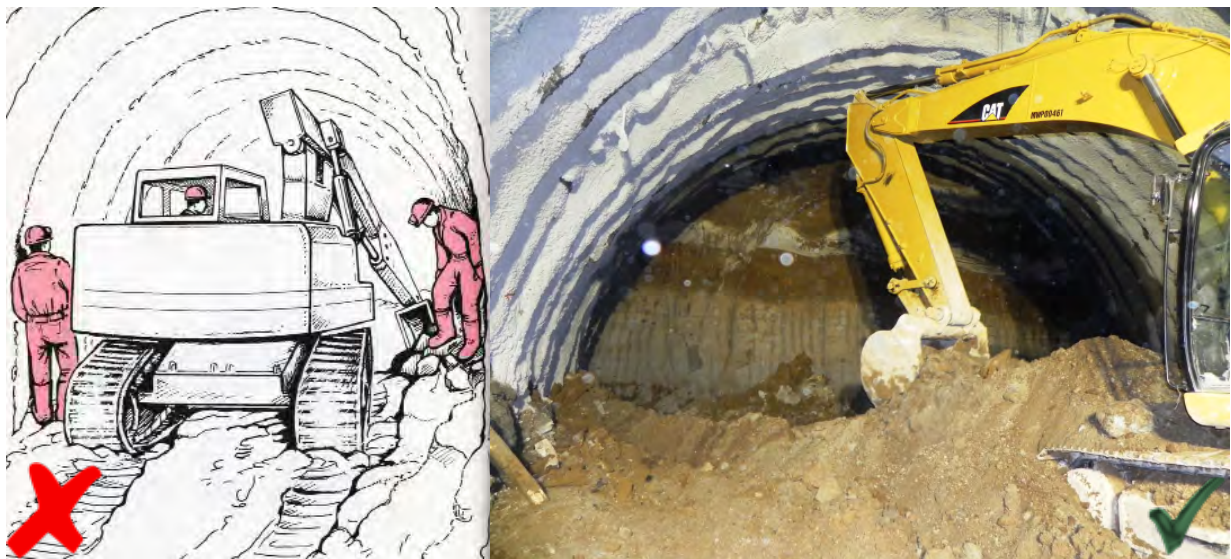
Figura 18.25. Evitar situarse o pasar entre la máquina y los hastiales mientras la retroexcavadora realiza la excavación.
