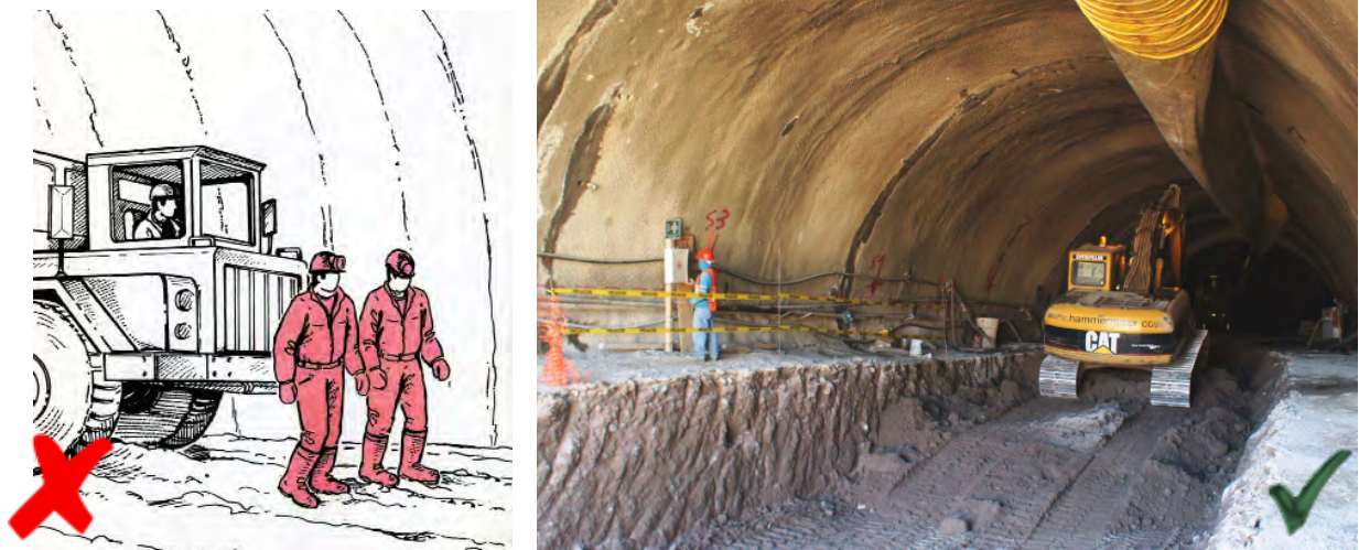
Figura 18.17. La correcta circulación del personal de obra es primordial para evitar ser atropellado.
