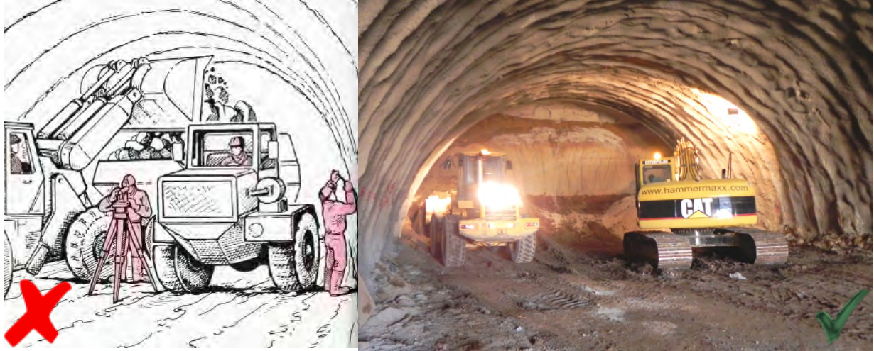
Figura 18.28. El personal de obra no debe obstaculizar la circulación de maquinaria durante el retiro de material producto de excavación.
