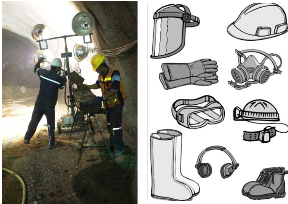
Figura 18.32. El equipo de protección depende de la actividad a realizar al interior o exterior del túnel.
