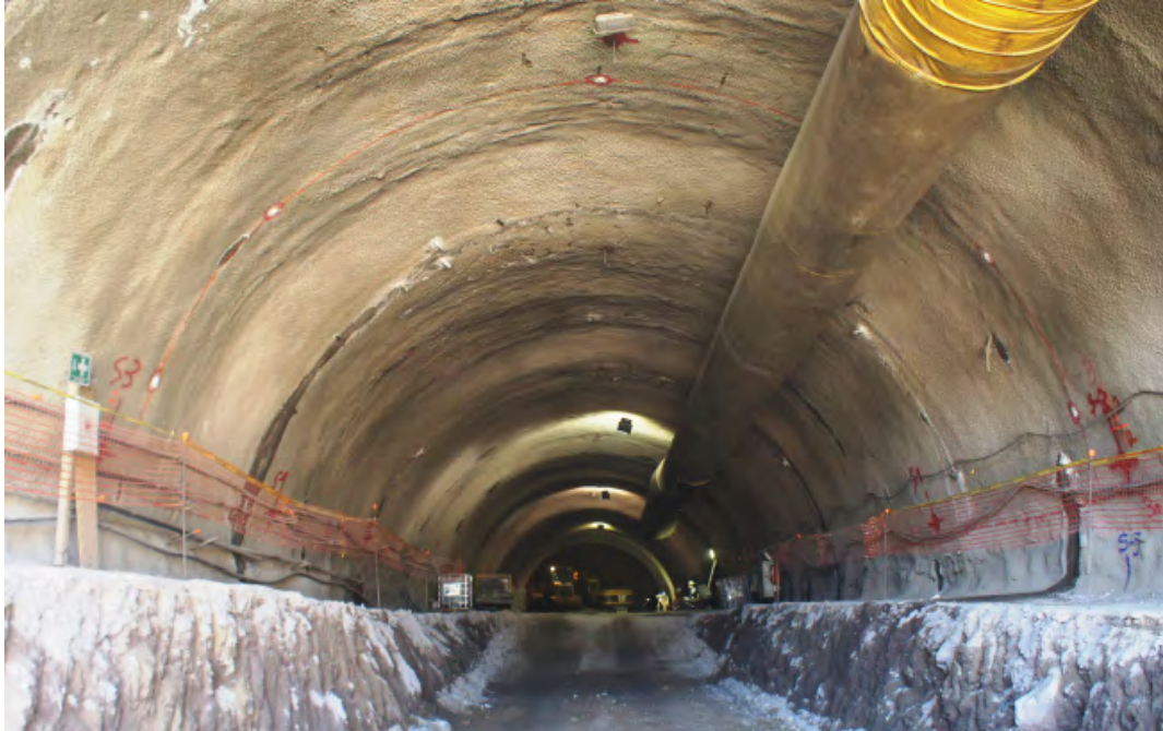
Figura 18.16. Interior del túnel con doble pasarela peatonal y zona de tránsito vehicular libre de personal.
