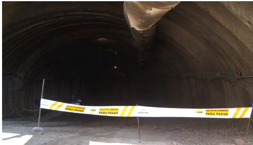
Figura 18.43. Colocación de cintas de precaución e informativas de voladura en la zona del portal del túnel.
