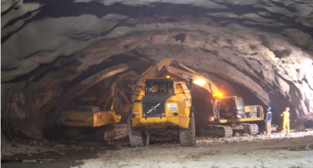
Figura 18.24. Personal de obra en zona de seguridad debido al retiro de material producto de la excavación.
