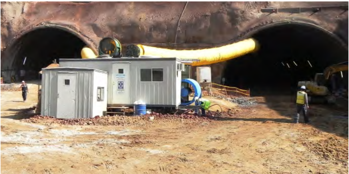
Figura 18.1. Caseta de control de acceso a obra.
