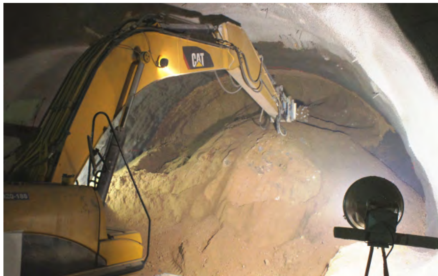
Figura 18.27. Frente de excavación excavado con retroexcavadora y cabezas rotatorias de corte.
