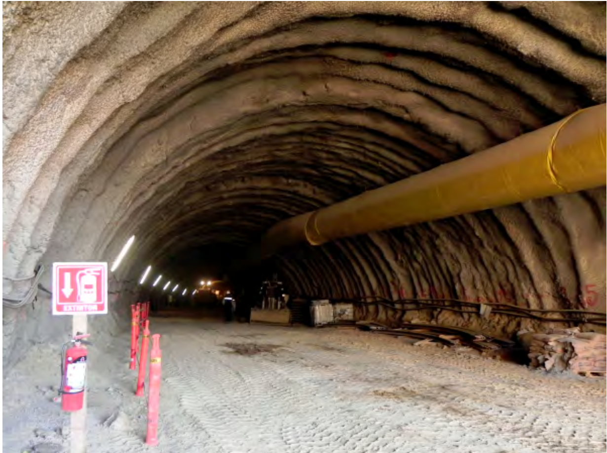
Túnel Desierto De Los Leones, Súper Vía Poniente, Distrito Federal
