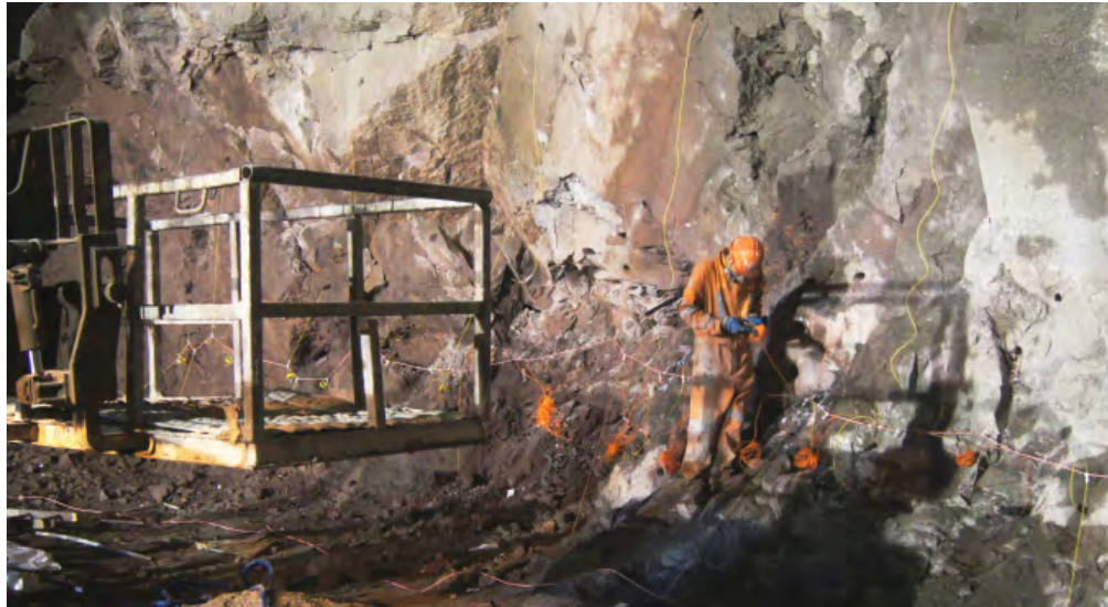
Figura 18.41. Personal capacitado para la manipulación de explosivos, colocación de cordón detonante.
