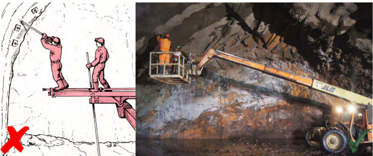
Figura 18.34. Instalación de anclas mediante maquinaria adecuada para la acción de trabajo a realizar.
