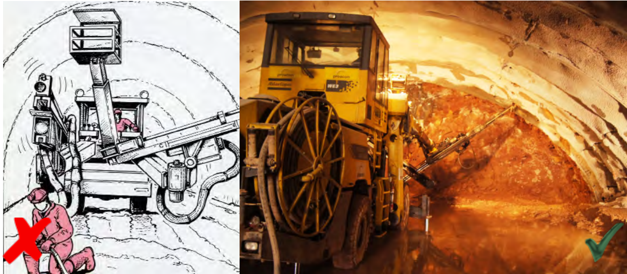
Figura 18.33. Trabajos de perforación con jumbo, las zonas de trabajo próximas deberán estar libres de personal de obra para evitar ser golpeado o aplastado.
