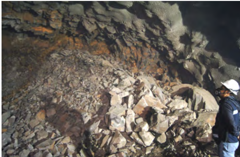
Figura 18.44. Verificación del frente de excavación después de la realización de la voladura.
