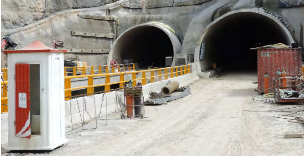
Figura 18.23. Sanitarios portátiles colocados en un área próxima al portal del túnel.
