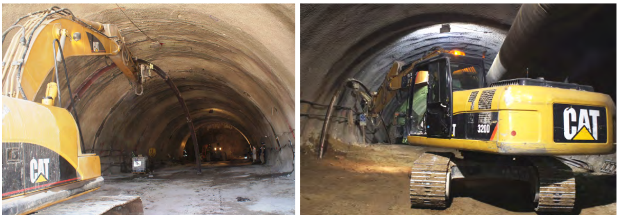
Figura 18.29. Transporte de marco metálico hacia el frente de excavación mediante retroexcavadora.
