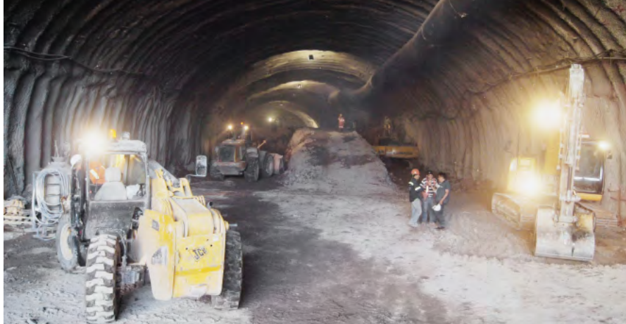
Figura 18.31. Ubicación de 4 máquinas laborando al mismo tiempo en diferentes zonas del interior del túnel.
