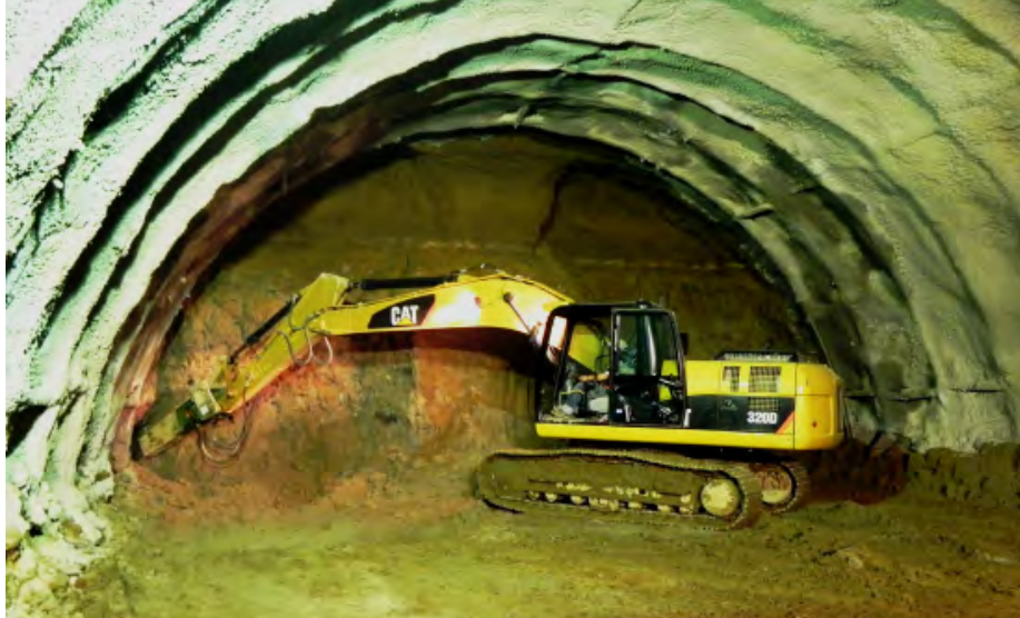
Figura 18.26. Retroexcavadora con rotomartillo hidráulico realizando excavación en el frente del túnel.
