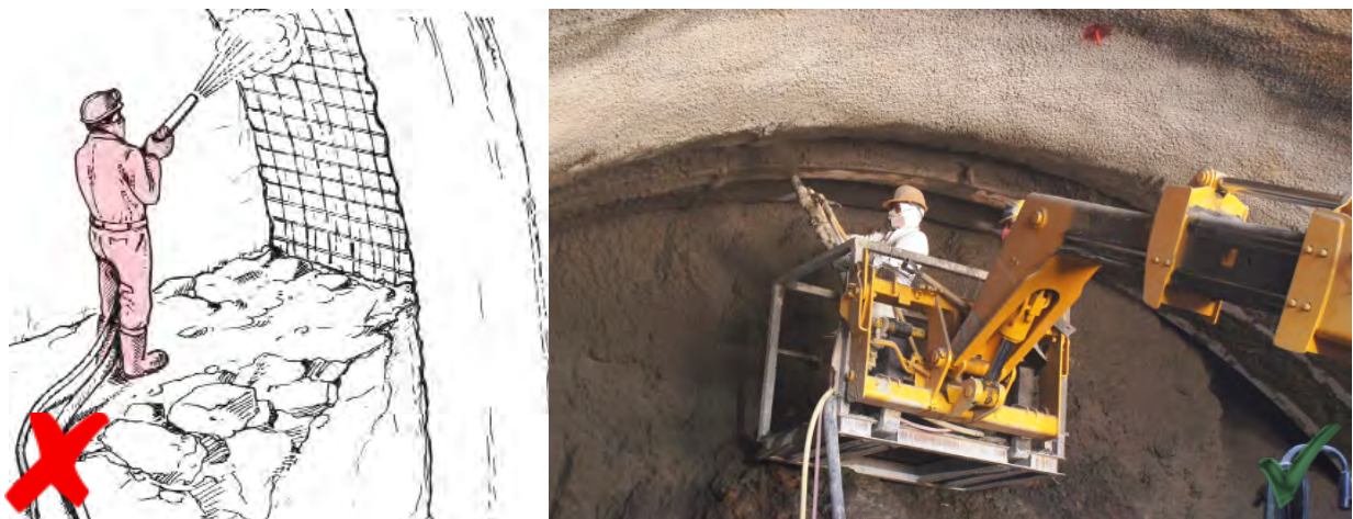
Figura 18.38. Lanzado de concreto usando manipulador telescópico para el caso de uso de bomba manual.
