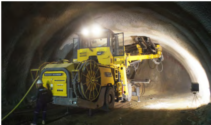
Figura 18.9. Iluminación en los equipos de construcción e iluminación para ejecutar los trabajos.
