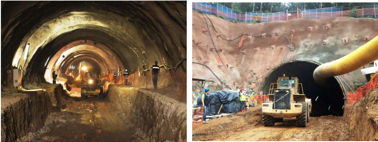
Figura 18.18. El personal de obra deberá estar atento a la circulación vehicular en todo momento.
