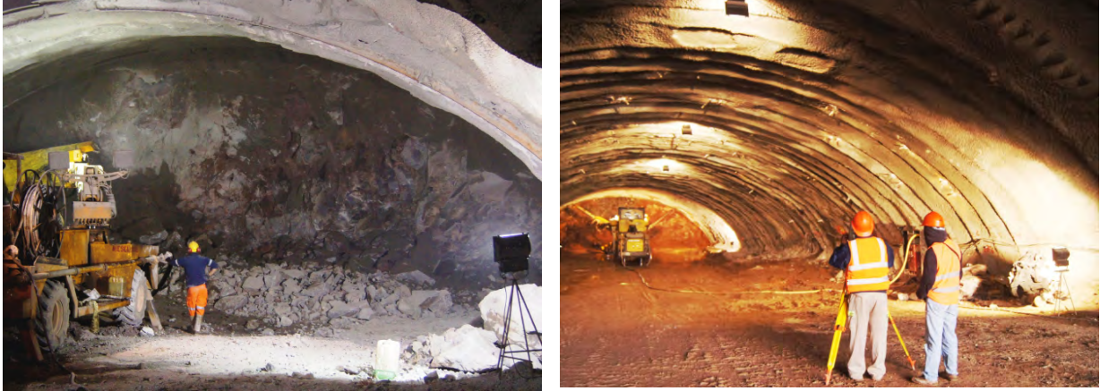
Figura 18.8. Deben estar iluminados todos los lugares de trabajo y vías de circulación.
