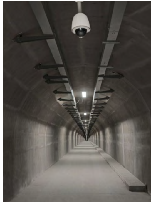
Figura 17.3. Galería de emergencia.
