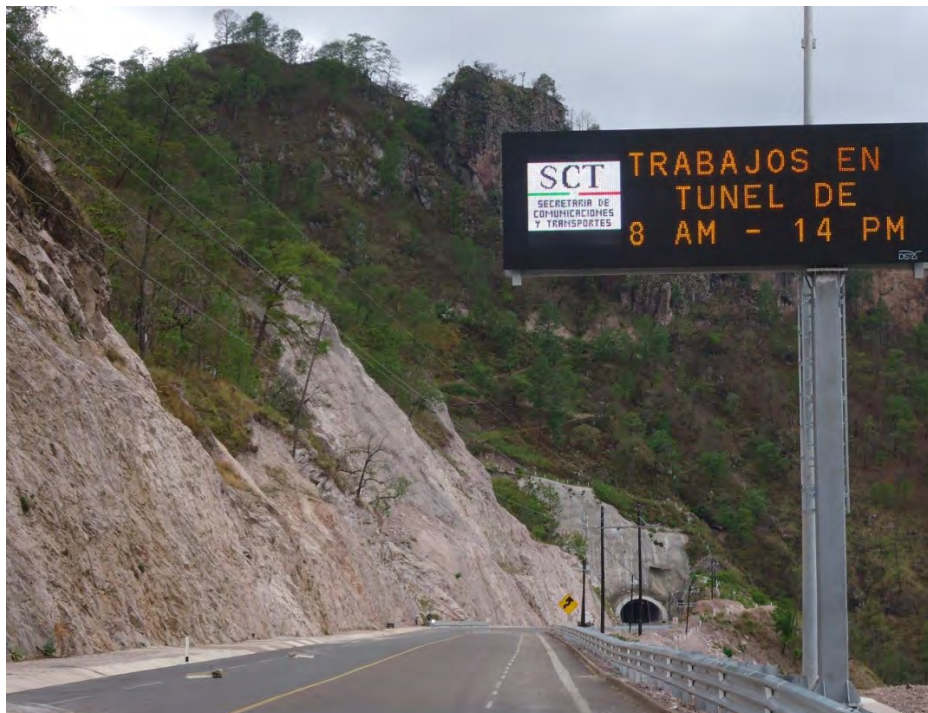
Figura 17.24. Paneles de mensajes variables.
