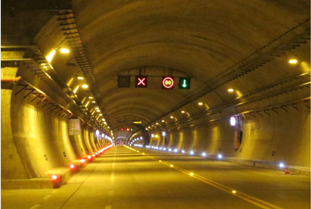
Túnel El Sinaloense, Carretera Durango - Mazatlán
