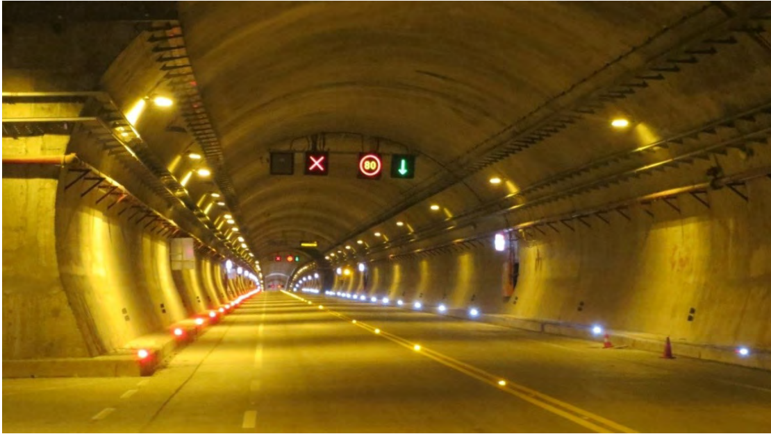
Figura 17.23. Paneles de Señalamiento.
