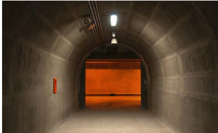
Figura 17.2. Galería de conexión.
