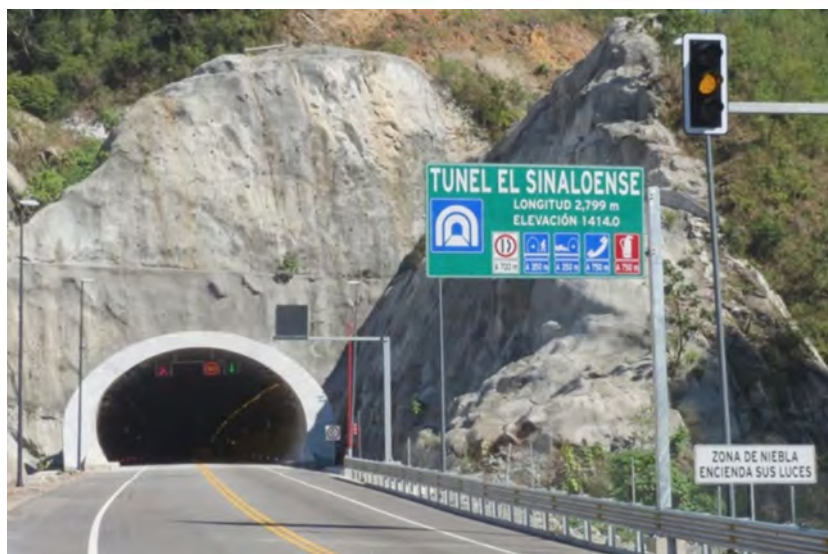
Figura 17.17. Señal 2 Nombre del túnel (túneles equipados).
