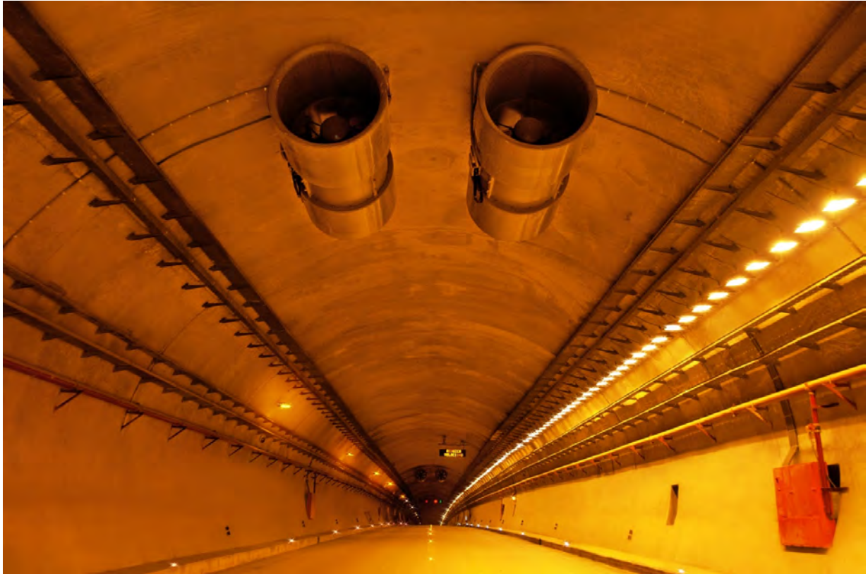
Túnel El Sinaloense, Carretera Durango-Mazatlán
