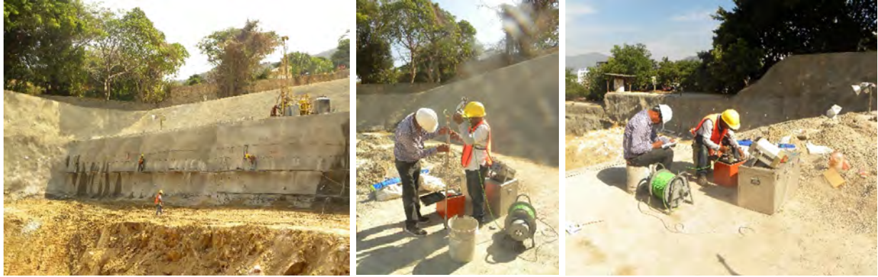
Figura 13.11. Instalación de inclinómetros en el emportalamiento de un túnel.
