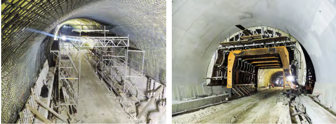
Figura 13.17. Armado de la bóveda y colado completo del revestimiento definitivo.
