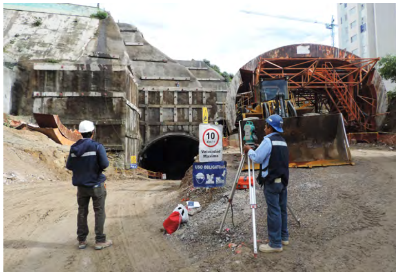
Figura 13.12. Medición de referencias topográficas en el portal de un túnel.
