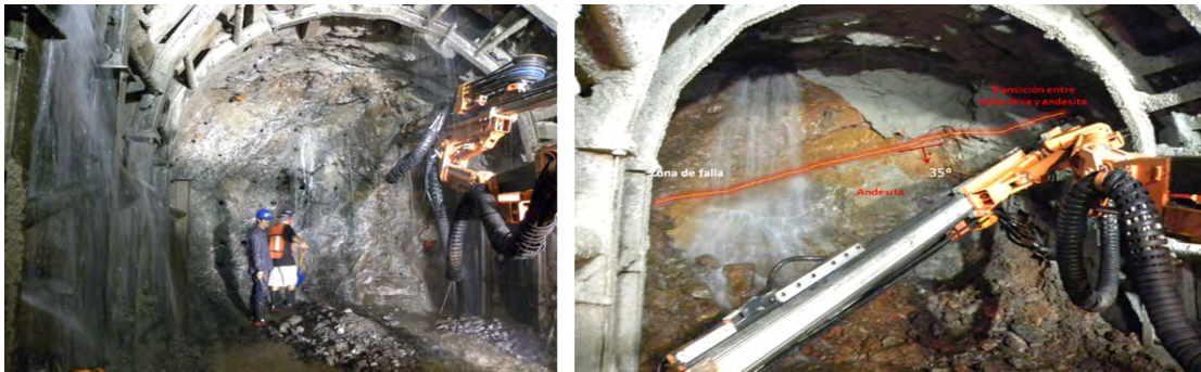
Figura 13.15. Presencia de agua durante la excavación de la galería de emergencia, túnel El Sinaloense.
