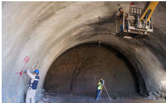
Figura 13.13. Equipos de medición: a) Distometer y b) Cinta Extensométrica.
