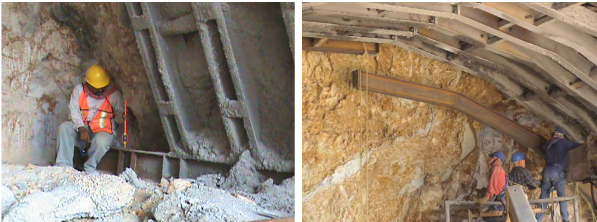
Figura 13.7. Verificación durante la implementación de los marcos metálicos.
