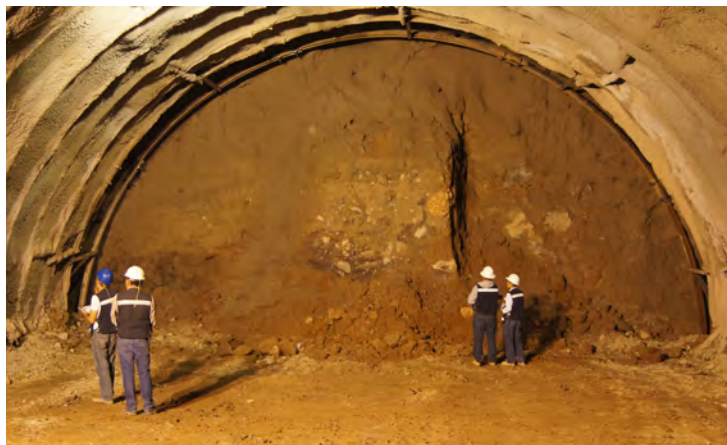
Figura 13.4. Levantamiento geológico estructural del frente de excavación en un túnel.
