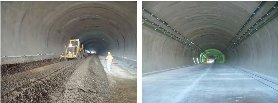
Figura 13.18. Construcción de la base hidráulica y pavimento de concreto en el interior del túnel.
