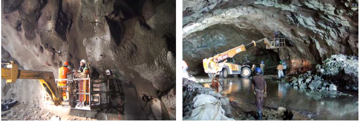
Figura 13.9. Verificación durante la perforación e instalación del anclaje.
