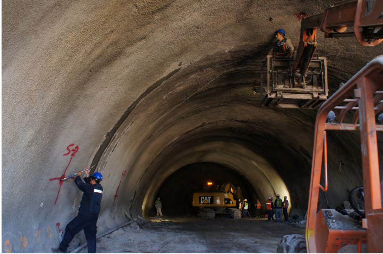
Túnel Luis Cabrera, Supervía Poniente. Consultec Ingenieros Asociados, S.C.
