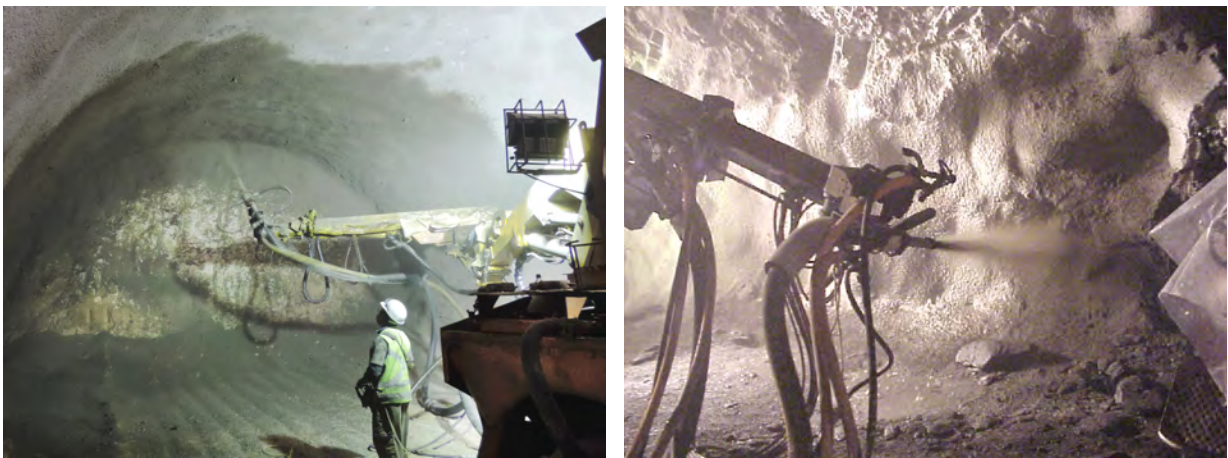
Figura 13.8. Verificación de la colocación del concreto lanzado.
