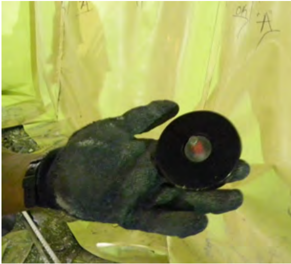
Figura 12.9. Disco de PVC para fijación de geomembrana.
