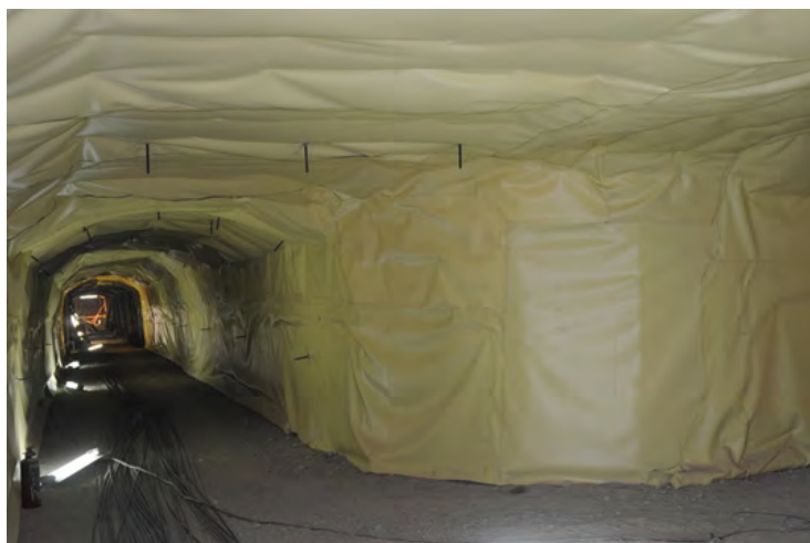
Figura 12.5. Colocación de membrana de impermeabilización ajustable a la geometría del túnel.
