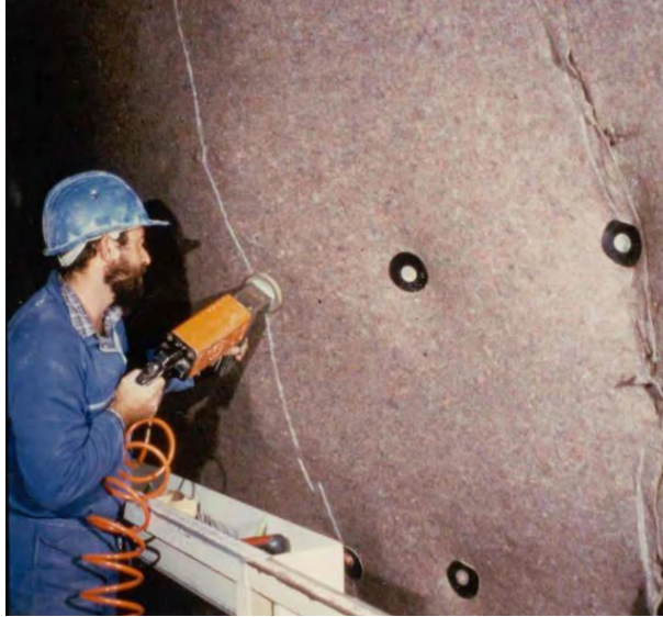
Figuras 12.4. Colocación de geotextil.
