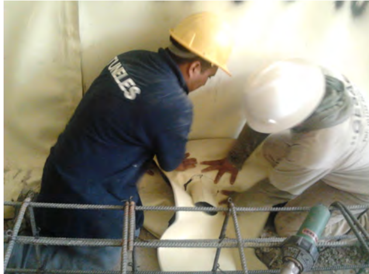
Figura 12.18. Impermeabilización de bajada a dren colector principal.
