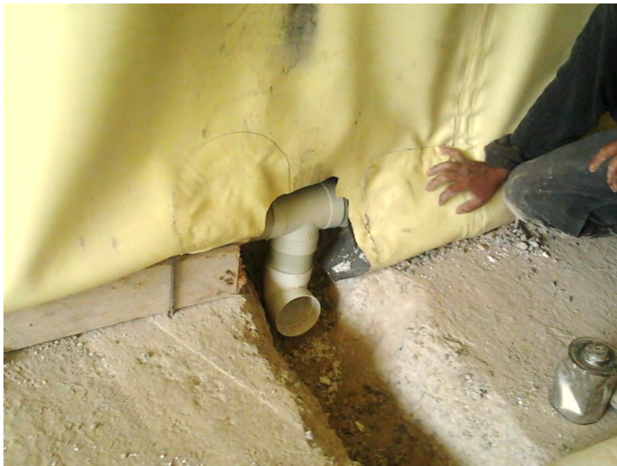
Figura 12. 17. Bajada a dren colector principal.
