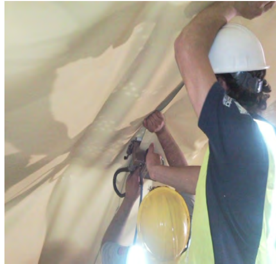
Figura 12.10. Termofusión de geomembrana.
