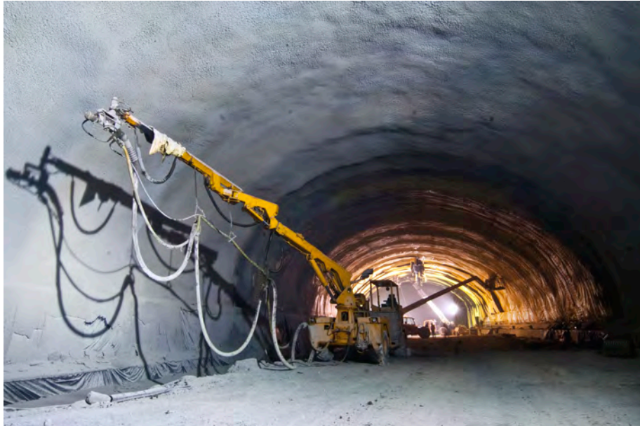
Figura 11.20. Acabado final del revestimiento de concreto lanzado en el túnel Chimalpa I. Carretera Toluca-Naucalpan. Consultec Ingenieros Asociados, 2015.
