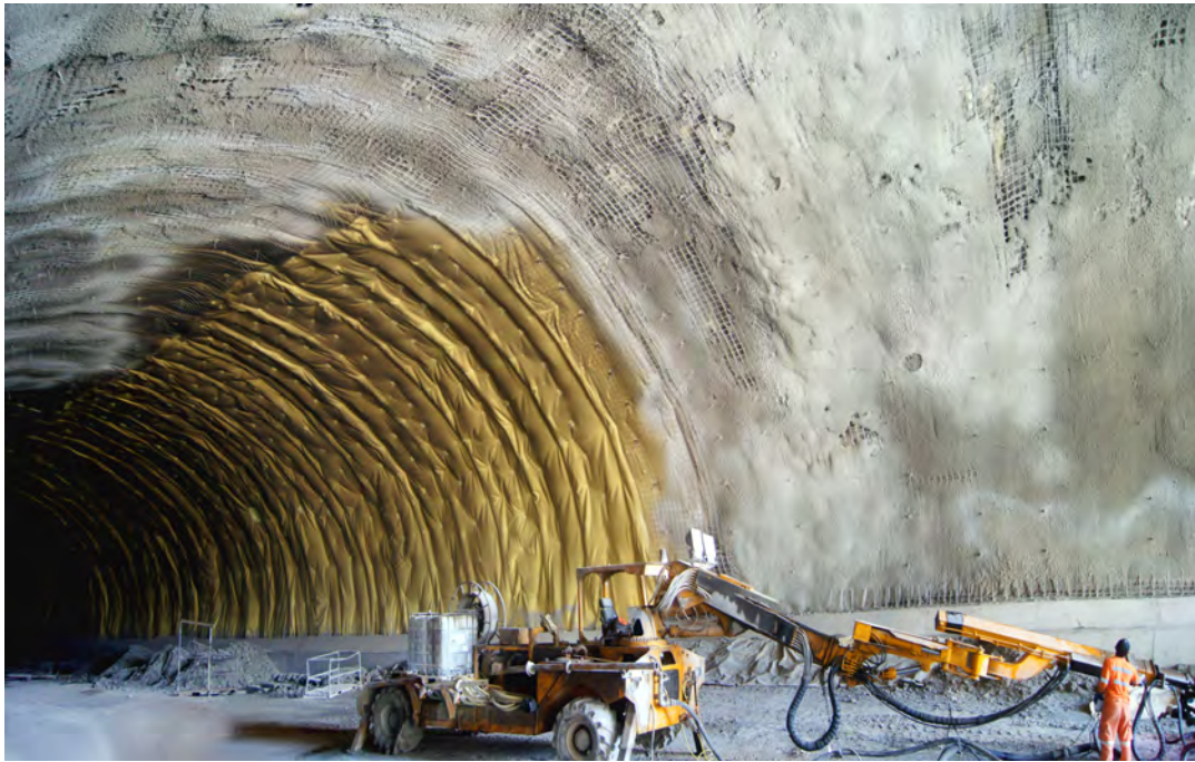
Figura 11.8. Primeras capas de lanzado sobre la geomembrana. Túnel Chimalpa I. Carretera Toluca-Naucalpan. Consultec Ingenieros Asociados, 2015.
