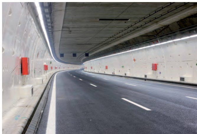
Figura 11.26. Pintura cerámica aplicada sobre dovelas. Tomada de Alliance [Ref. 3 ].
