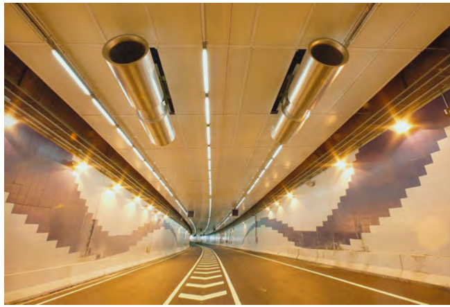
Figura 11.25. Pintura cerámica aplicada directamente sobre el concreto. Tomada de Alliance [Ref. 3].
