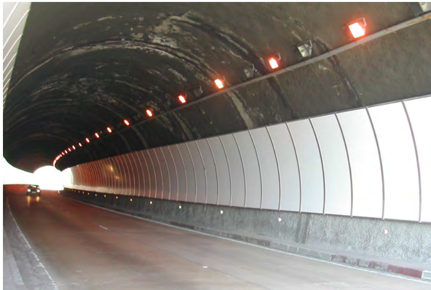
Figura 11.4. Revestimiento parcial con paneles prefabricados, Túnel Loma Larga Monterrey, México.
