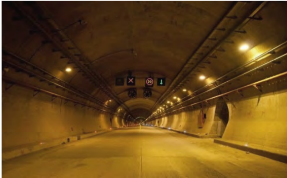
Figura 11.3. Revestimiento completo concreto hidráulico, Túnel Carretera Durango Mazatlán, México.
