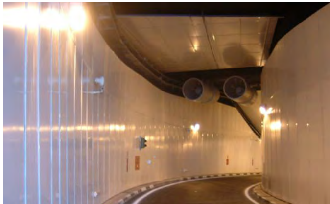
Figura 11.12. Colocación de paneles en clave y hastiales. Tomada de Alliance [Ref. 3 ].
