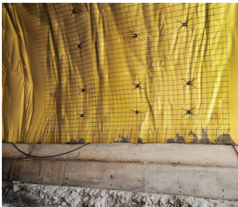
Figura 11.7. Sujeción de la malla electrosoldada mediante “arañas”. Túnel Chimalpa I. Carretera Toluca-Naucalpan. Consultec Ingenieros Asociados, 2015.
