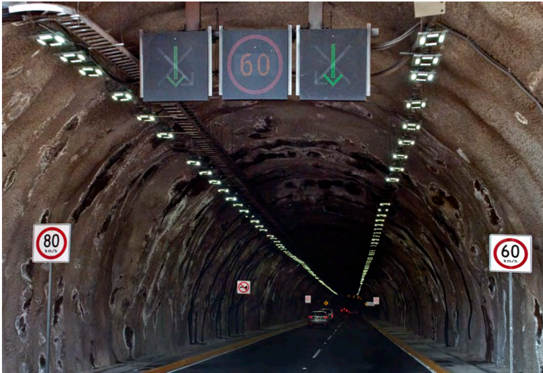
Figura 11.10. Túnel revestido con concreto lanzado sin un sistema de drenaje adecuado. Túnel la Loma, Supervía Poniente, Ciudad de México.
