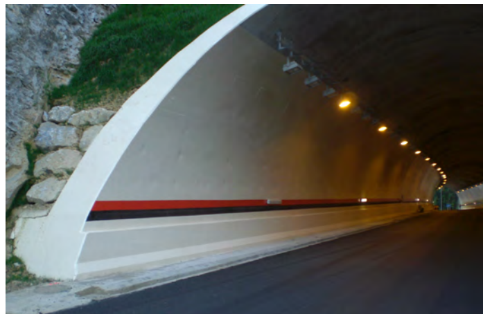
Figura 11.24. Pintura cerámica aplicada directamente sobre el concreto. Tomada de Alliance [Ref. 3 ].
