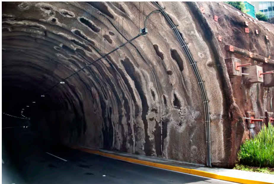
Figura 11.2. Concreto Lanzado como revestimiento. Túnel en la Supervía Poniente de la Ciudad de México.
