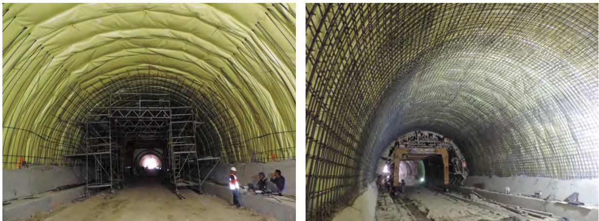
Figura 11.14. Colocación de acero en clave y hastiales.
