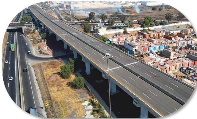
Vialidad Principal al AIFA. Camino Tonanitla, Nextlalpan-Estado de México
