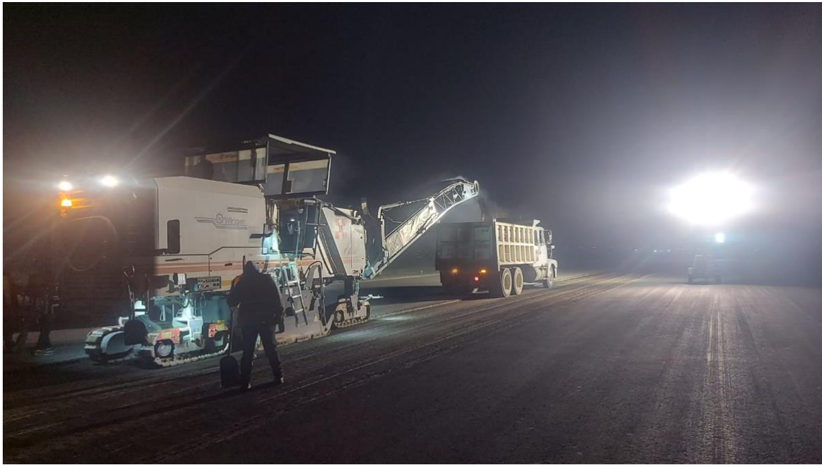
Pista 17-35 del Aeropuerto Internacional de Puebla, Puebla
