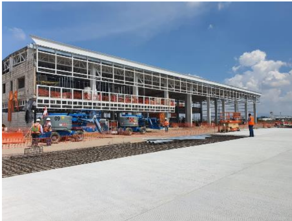
Construcción del Salvamento y Extinción de Incendios (SEI). Aeropuerto de Guadalajara
