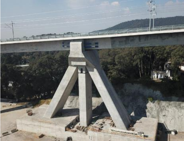
Tramo I: Viaducto 2 Tren Interurbano México-Toluca
