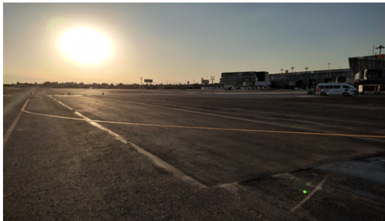
Corte y reposición de carpeta asfáltica en rodaje bravo en el AICM
