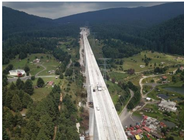
Tramo I: Viaducto 5 Tren Interurbano México-Toluca
