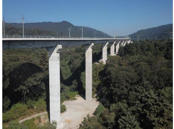
Tramo I: Viaducto 4 Tren Interurbano México-Toluca
