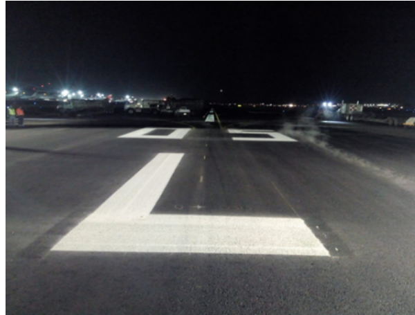
Rehabilitación de la pista 05L-23R en el AICM
