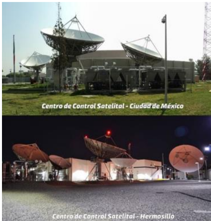
TELECOMM, Centros de Control Satelital en Iztapalapa, CDMX y Hermosillo, Son
