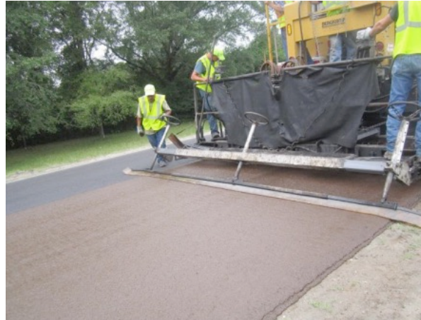
Trabajos de conservación
