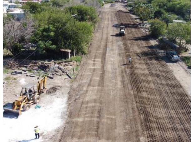
Vialidad de Acceso al Puente Internacional B&M
