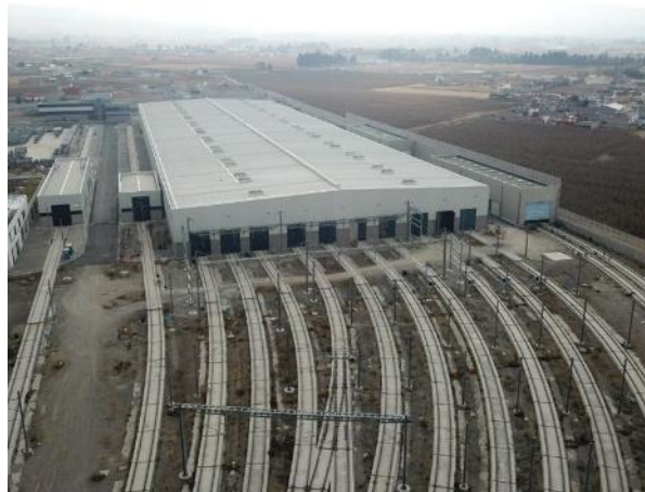
Tramo V: Playa de vías Tren Interurbano México-Toluca
