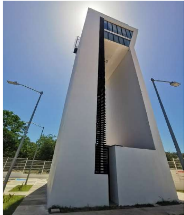
Foto: Nueva torre de control Aeropuerto de Chetumal, Quintana Roo.
