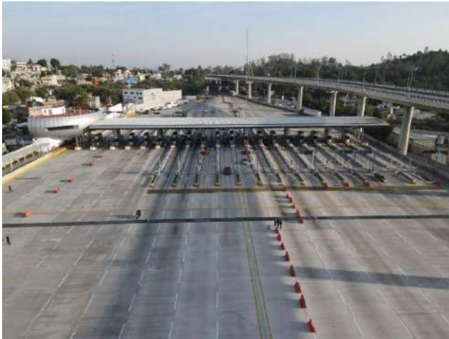
Foto: Caseta segura
