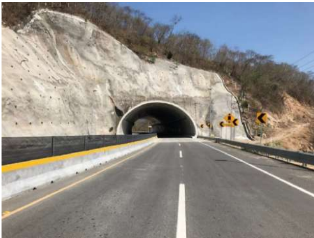
Foto: Uno de los tres túneles del Libramiento Poniente de Acapulco, en Guerrero.
