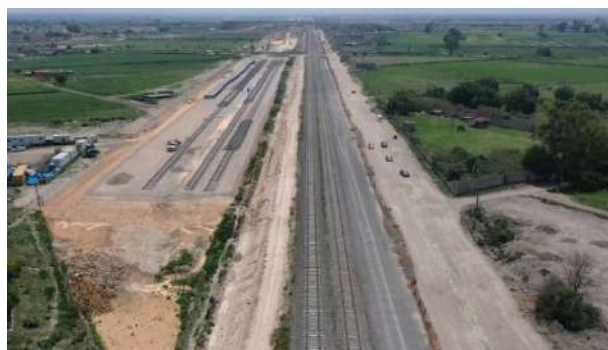
Foto: Nuevo Patio Ferroviario, Ampliación del Suburbano, en estado de México
