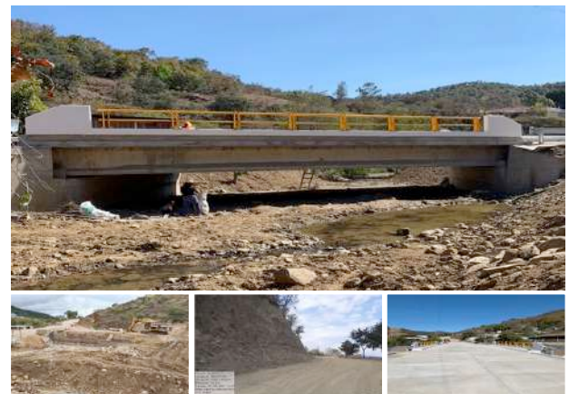
Foto: Puente ubicado en el km 7+100, sobre el camino E.C.(Huajuapam - Oaxaca) – La Joya - San Andrés Nuxiño, en Oaxaca.
