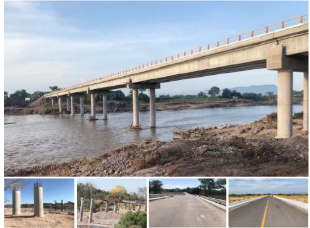
Foto: Puente "Río San Pedro", ubicado en el km 0+430 del camino: Ruíz – El Ochenta, en Nayarit
