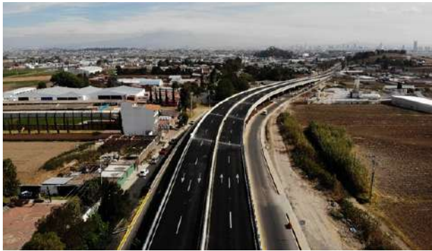
Foto: Libramiento de Ensenada, en Baja California
