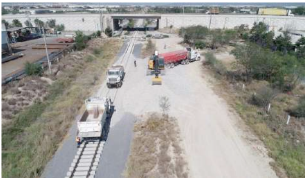
Foto: Libramiento Ferroviario de Monterrey, en Nuevo León
