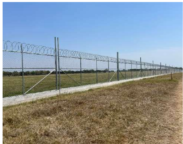
Foto: Cercado perimetral del Aeropuerto de Tamuín, San Luis Potosí.
