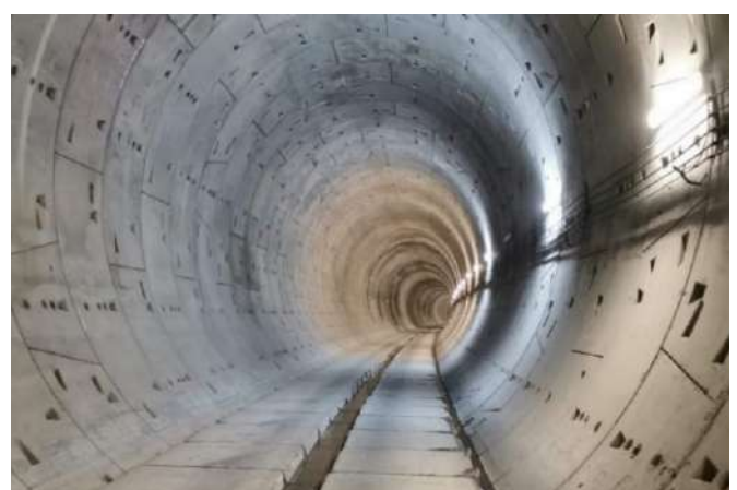
Fotos: Tramo II Obra Civil 100%, en estado de México
