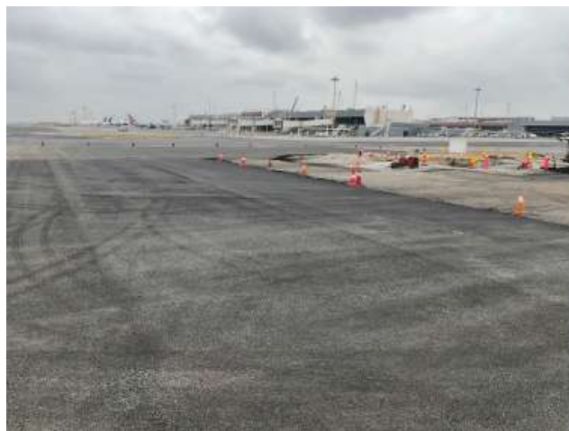
Foto: Rehabilitación de rodajes en el Aeropuerto Internacional de Monterrey.
