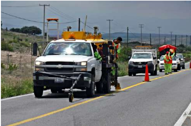
Foto: Señalamiento horizontal, tramo: Celaya – Ojuelos, en Guanajuato.
