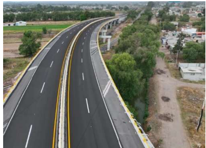
Foto: Puente Nexquipayac de la autopista Ecatepec-Peñón, en el estado de México.
