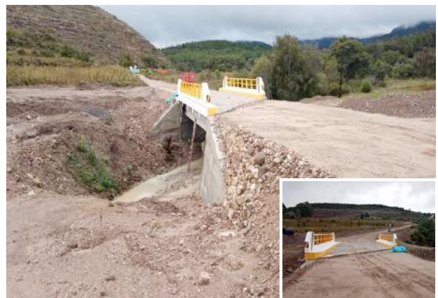
Foto: Puente ubicado en el km 0+530, sobre el camino E.C. (Magdalena Jicotlán – Tlacotepec Plumas) – San Mateo Tlapiltepec, en Oaxaca.
