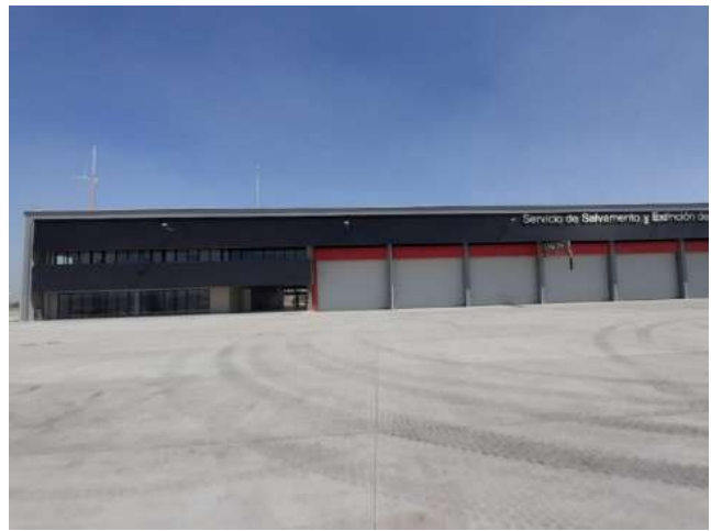
Foto: Estación de Servicio de Salvamento y Extinción de Incendios del Aeropuerto Internacional de Guadalajara.
