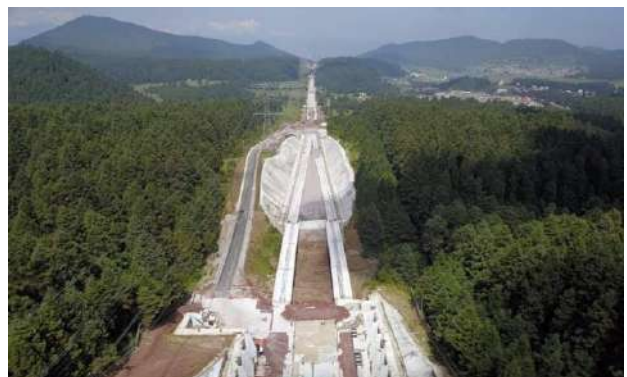
Foto: Tramo I Obra Civil 100%, en estado de México
