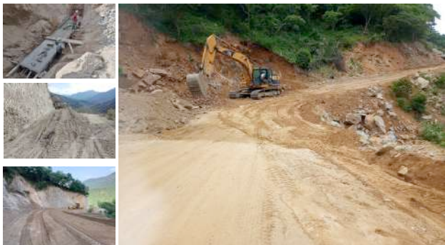
Fuente: E.C. (Mitla - Ent. Tehuantepec II) - San Juan Lachixila, del km 0+000 al km 13+560, en Oaxaca
