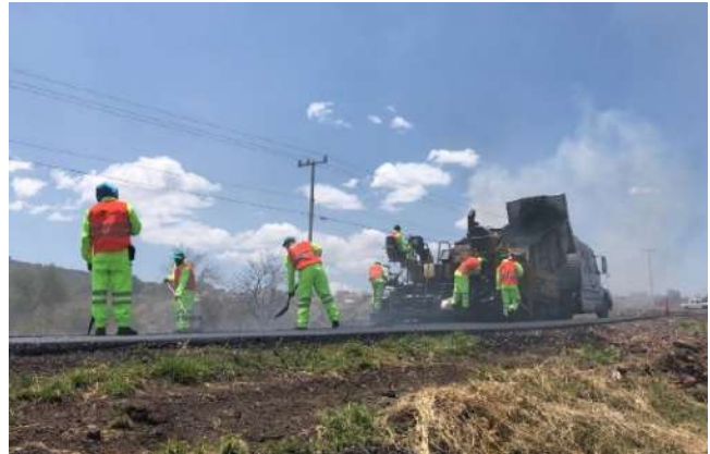
Foto Trabajos de Conservación Periódica de tramos, tramo: Jiquilpan-Lim. Edos. Mich./Jal., en Michoacán.
