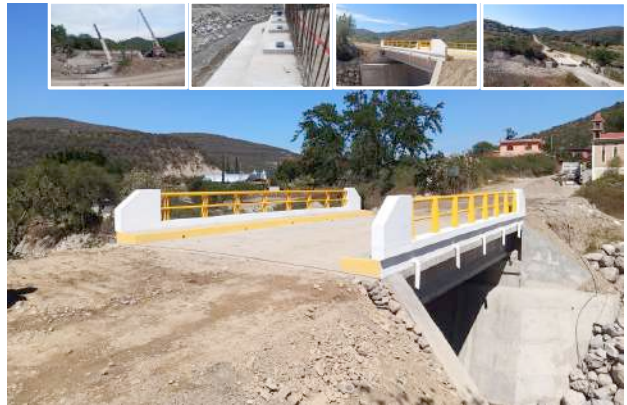
Foto: Puente ubicado en el km 0+180, sobre el camino E.C. (Ixpantepec Nieves – Silacayoapam) – Santiago del Río, en Oaxaca.
