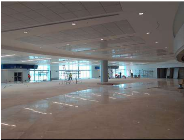
Foto: Sala de última espera del edificio Terminal 4 del Aeropuerto Internacional de Cancún.
