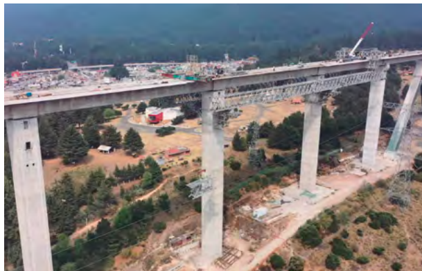
Foto. Tramo I. Tren Interurbano México-Toluca.
