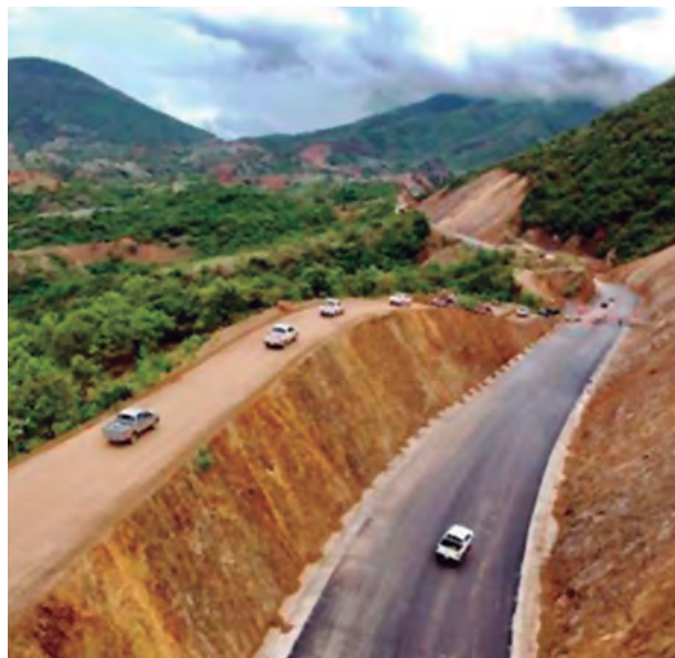
Foto. Autopista Barranca Larga-Ventanilla. Junio de 2021.
