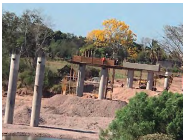
Foto. Puente "El 80" del Municipio de Ruíz, en Nayarit.
