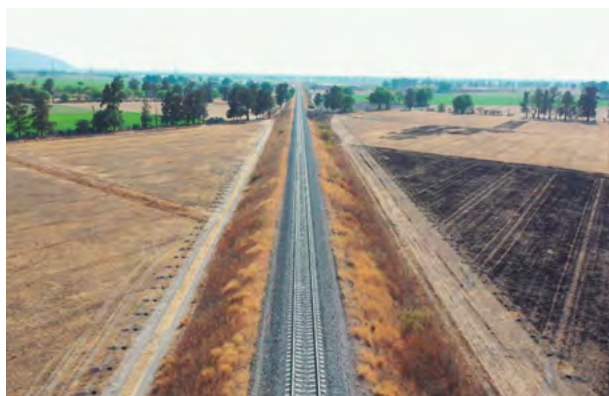
Foto. Libramiento Ferroviario de Celaya.
