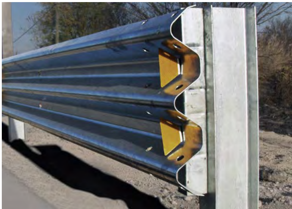
Figura 2 Reflejante en defensa de lámina galvanizada
